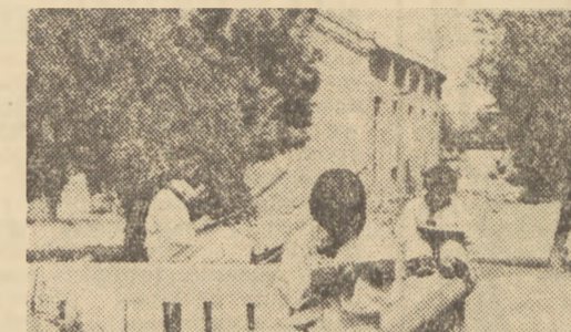
Prace przy budowie nowego gmachu Szkoły Inżynierskiej w Częstochowie.
