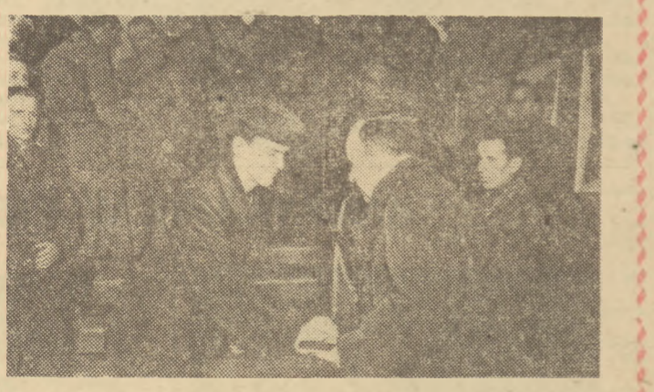
Zastąpił i ofiarą budowniczości taśmowca i wyrotnic otrzymali za swą pracę wysokie odznaczenia państwowe. M. in. Brązowy Krzyż Zasługi otrzymał ZMP-owiec kol. ZDZISŁAW DULA, uczeń Technikum Morsko-Nawigacyjnego w SZCZECINIE. Kol. Dula odznaczony został za ofiarę pracę na stanowisku kierownika brygady ochotniczej z TMN-u. Na zdjęciu: Minister Żeglugi ton. POPIEL wręcza odznaczenie kol. Duli. (KR.)
