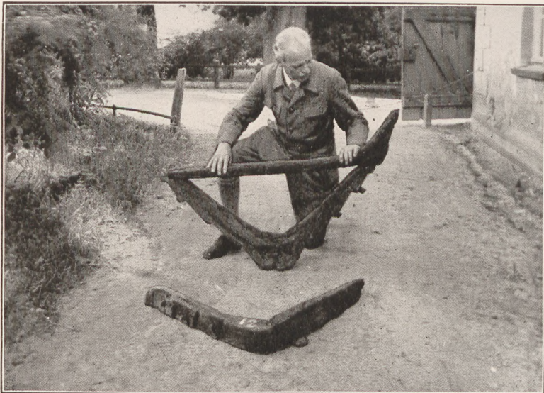
Abb. 22. Das Zusammenpassen von Ducht mit Knie und Spant 2 bei Boot III von Ohra (Prof. Lienau), davor Spant 3.
