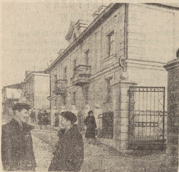
Nowe domy mieszkalne na ulicy Woroszyłowa w Sierpuchowie.
