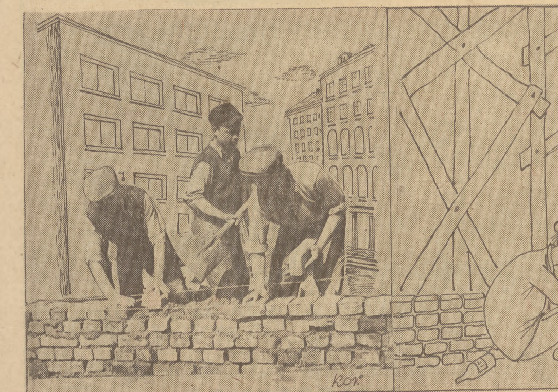
Samodzielną młodzieżową trójkę murarską pracuje z zapalem. Na zdjęciu murarze: J. Malinowski i Z. Pilaszek oraz podrzeczny W. Sobota.
