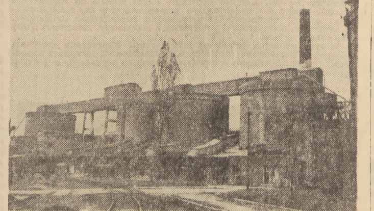
Cementownia w Godzcu, jedna z największych cementowni polskich od roku 1950 zaczęła zmieniać swe oblicze. Do chwili obecnej została już prawie całkowicie przebudowana, a urządzenia jej przeszły modernizację. Obecnie znajdują się w budowie: nowy mielinowy cementowy konstrukcji radzieckiej oraz urządzenia zaplecia technicznego. W październiku dzięki podjętym licznym zobowiązaniom wykonano plan produkcji klinkieru w 103,5 proc., a cementu w 101 proc.
