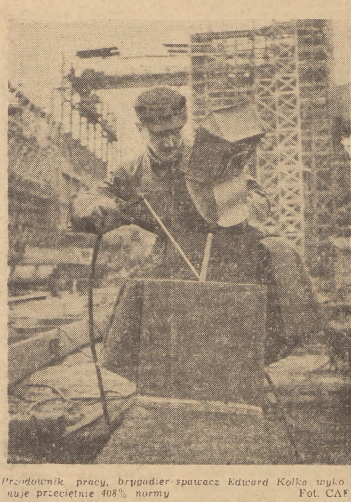
Pracownik przy budowie elektrowni Jaworzno II. Przewodnik pracy, brigadier spawacz Edward Kolka wykonuje przeciętnie 408% normy. Fot. CAF
