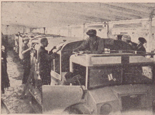
Seryjna budowa karoserii autobusów P. K. S.-u. Wykańczanie dachów.
