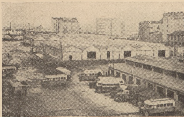
Ogólny widok zajezdni S.S.S.O. W głębi hale garażowe, po prawej stronie hala napraw bieżących.
