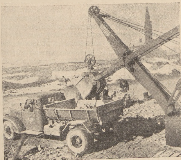
Zmechanizowany naładunek wywrotki 3,5 t. (foto Państw. Przeds. Budowlane).
