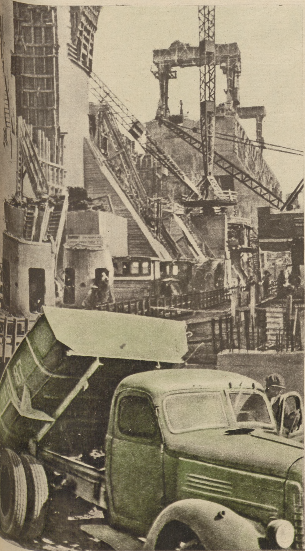
Roboty betonowe na budowie Ust-Kamienogrodzkiej Elektrowni Wodnej.
