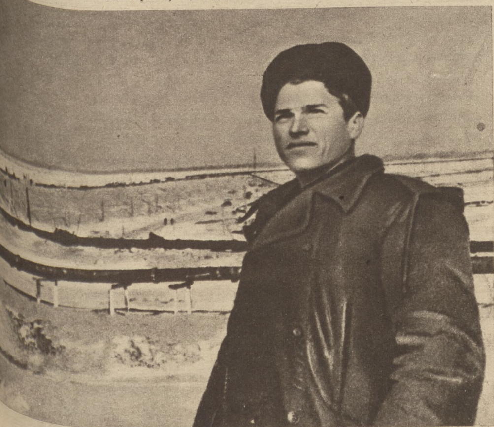
roboty na budowie Stalingradzkiej Elektrowni Wodnej. Na pierwszym planie — maszynista koparki, W. Dwornikow.
