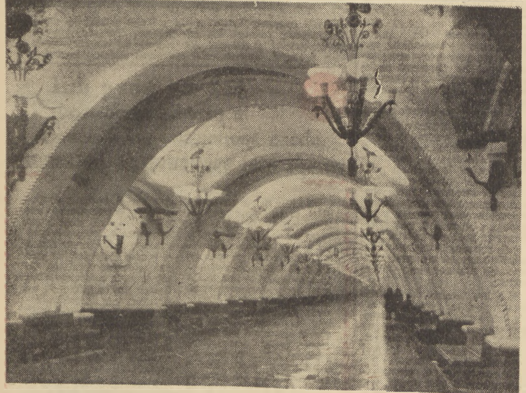
Centralna poczekalnia stacji „Arbatska”
