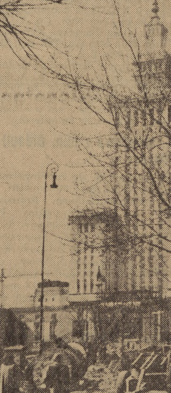
Wokół Pałacu Kultury i Nauki trwają intensywne prace. Ekipy Instytutu Techniki Budowlanej badają wytrzymałość gruntu oraz przepuszczalność gleby. Pod placem przeprowadzane są przewody instalacyjne, wodociągowe-kanalizacyjne, kable telefoniczne itp. Prawdopodobnie na jesieni bieżącego roku rozpocznie się budowę bloków mieszkaniowych wokół Placu. CAF - fot. Zdz. Wdowiński
