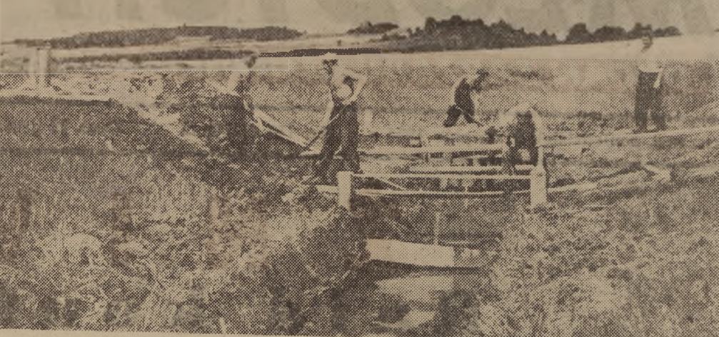
Prace melioracyjne na łakach spółdzielni produkcyjnej Jurowca, pow. Sanok (woj. rzeszowski). Fot. Kondracki — CAF
