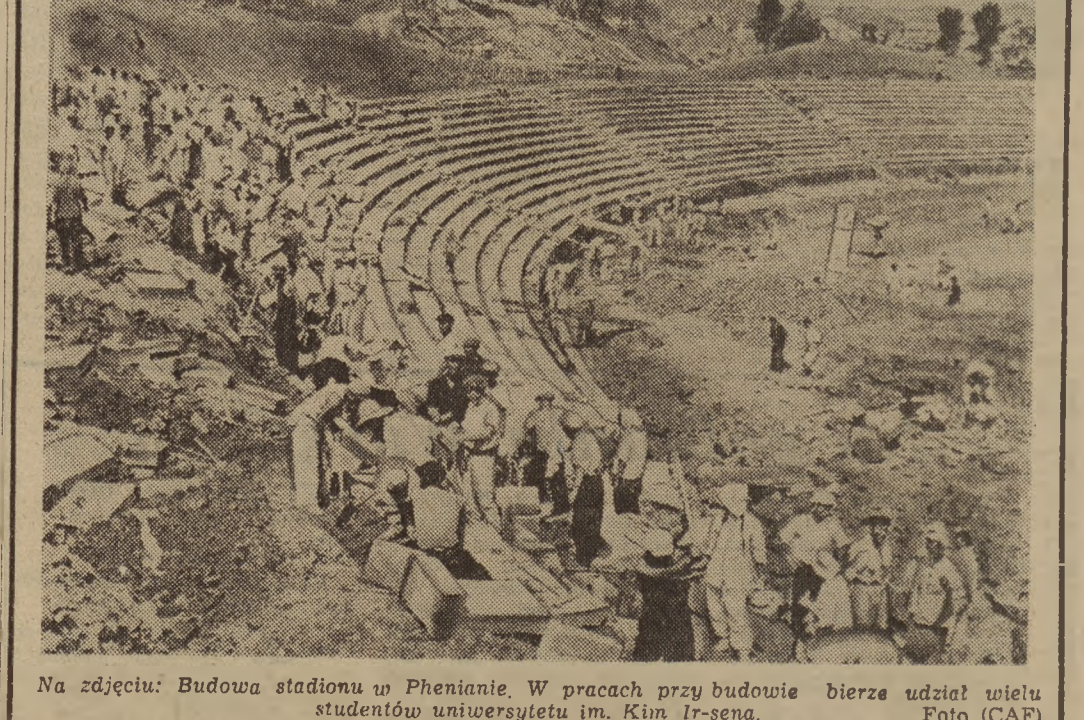
Na zdjęciu: Budowa stadionu w Phenianie. W pracach przy budowie bierze udział wielu studentów uniwersytetu im. Kim Ir-sena. Foto (CAF)
