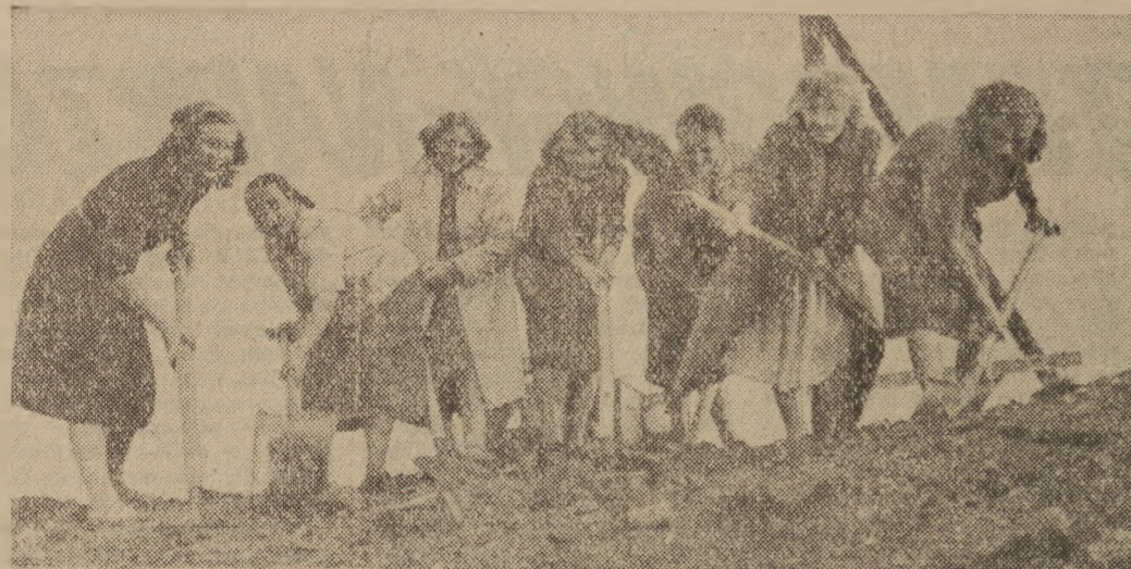
Dziewki ofiarne pomocy mieszkańcom Warszawy, prace przy budowie stadionu złotowego szybko postępują naprzód. Na zdjęciu: jedna z grup społecznych przy pracy.
