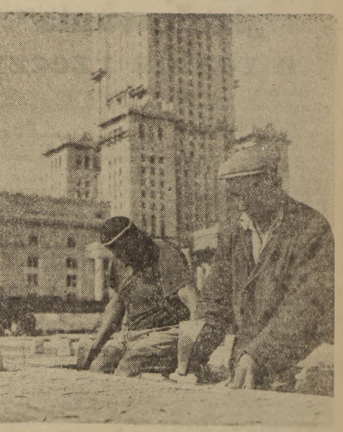
Na Pl. Stalina w Warszawie trwają intensywne prace przy układaniu mozaikowej nawierzchni. Mozaika układał artysta z kolorowych kostek bazaltu, porfiru i granitu...
