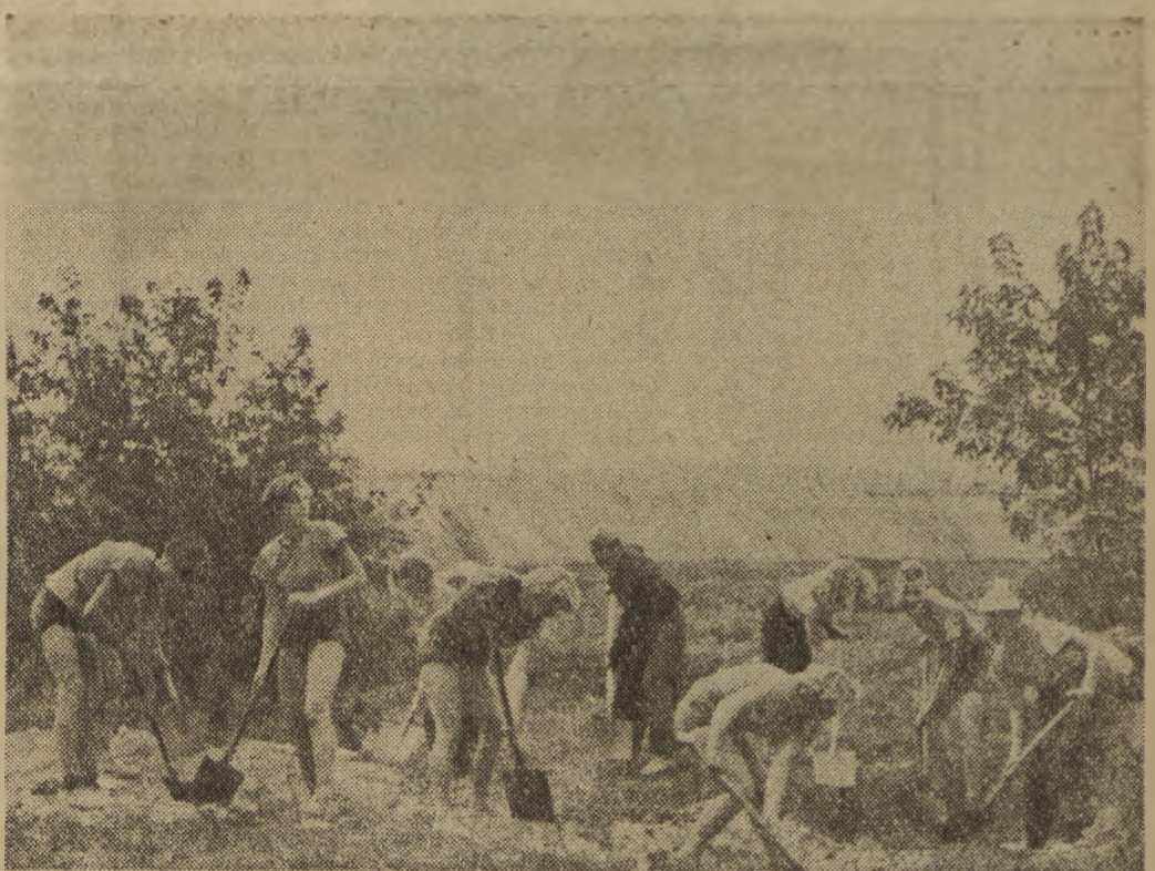
Obok młodzieży warszawskiej do pomocy przy budowie stadionu zgłosili się sportowcy wiejscy. Oni też chcą położyć swoją cegiełkę pod piękną inwestycję sportową w stolicy.
