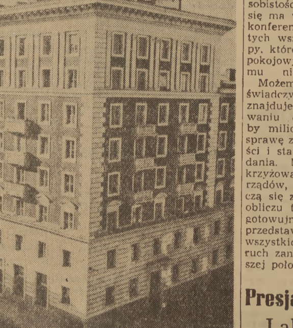
Na zdjęciu: nowy dom mieszkalny przy ul. Dondukowa. Foto: CAF
