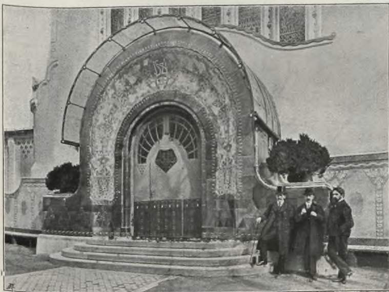
Portal des Künstlerhauses in Budapest. Vom Architekten Josef Vágó.
