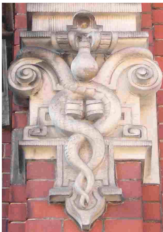
Główica pilastra z węzami i z żarówką Edisona z głównego portalu w elewacji południowo-wschodniej
