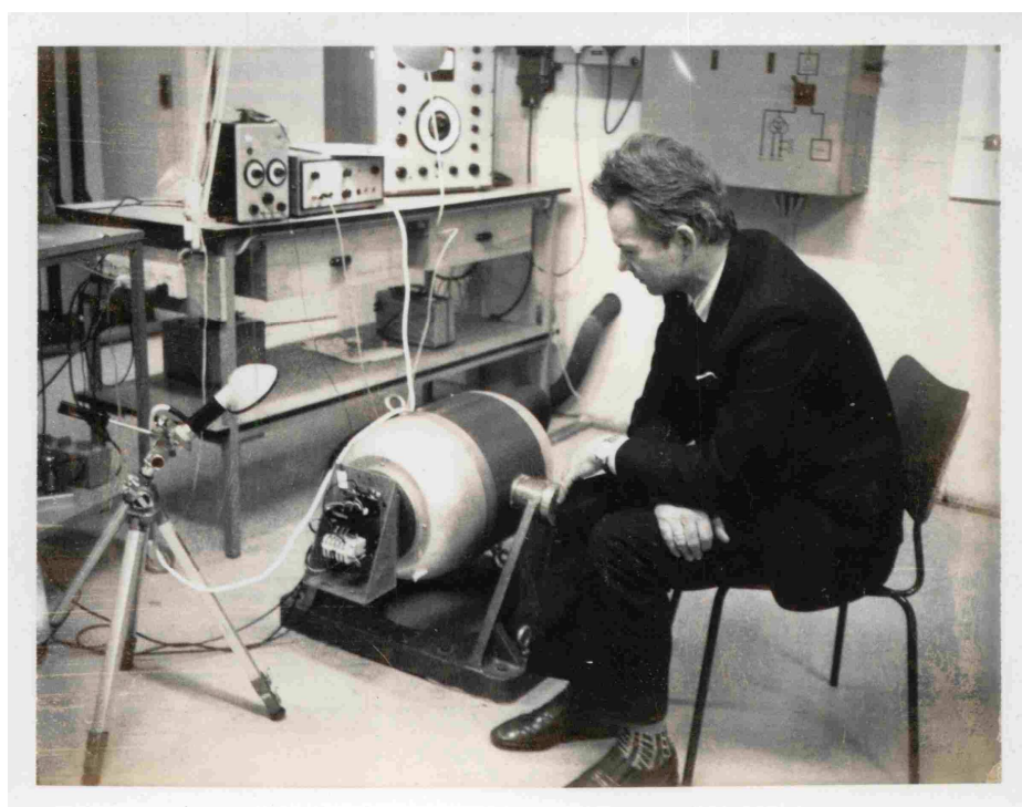
Edmund Dombrzalski podczas badania odporności stycznika elektrycznego na drgania w firmie Laur Knudsen w Kopenhadze (1972 rok)
