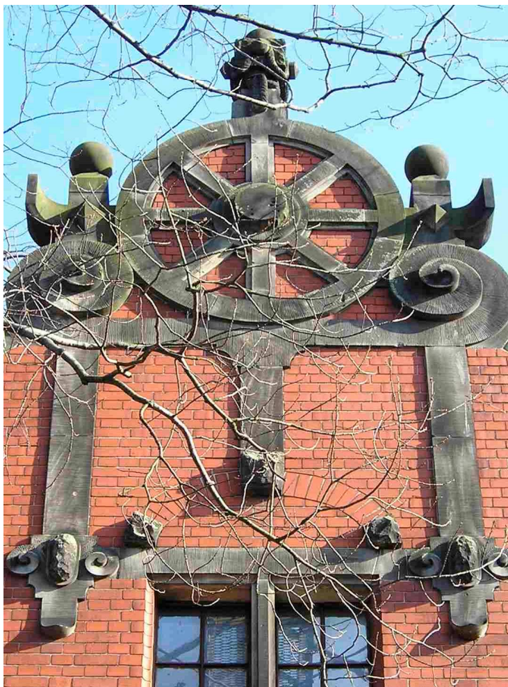
Szczyt w elewacji północno-zachodniej sali maszyn
