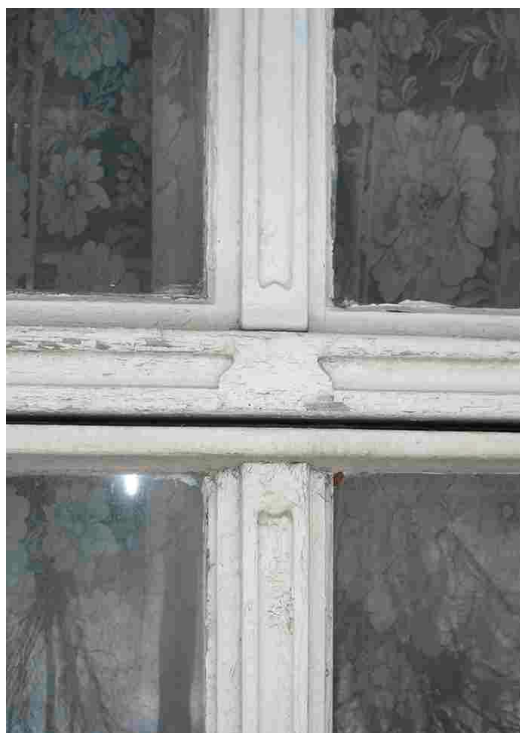
Fragment stolarki okiennej z ozdobnym profilowaniem w elewacji południowo-wschodniej
