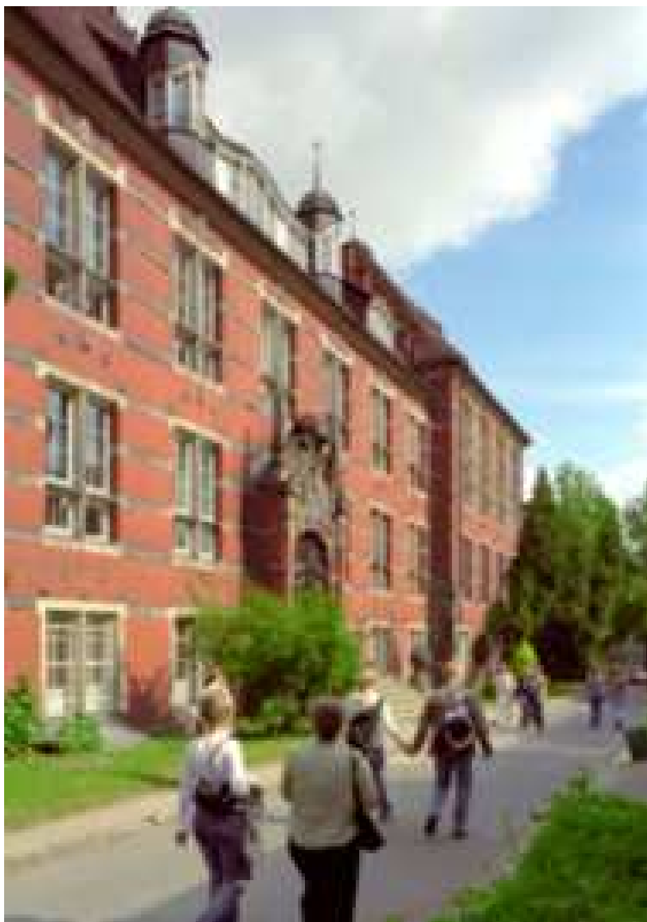
Gmach Wydziału Elektrotechniki i Automatyki im. Profesora Kazimierza Kopeckiego Fot. Krzysztof Kempek
