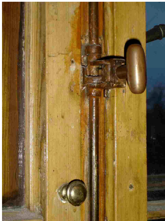
Fragment stolarki okiennej z częścią zabytkowej zasuwnicy z klameczką w wielkiej sali audytornej (E-41)
