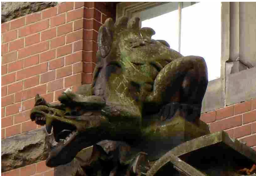
Zwieńczenie tympanonu rzeźbą smoka z głównego portalu w elewacji południowo-wschodniej
