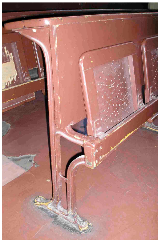
Żeliwna konstrukcja siedziska oraz pulpitu w małej sali audytoryjnej (E-27)
