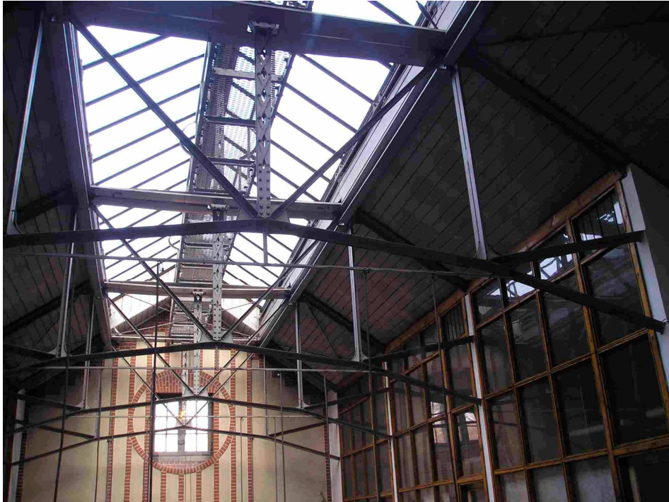
Widok na górne partie ścian i metalową konstrukcję dachu sali maszyn
