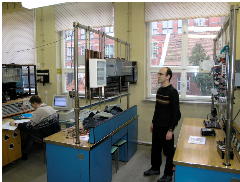
Laboratorium elektroenergetycznej automatyki zabezpieczeniowej. Zajęcia prowadzi dr inż. Jacek Klucznik
