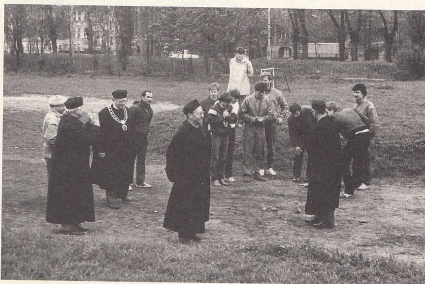
Dziekan Zbigniew Szczerba (trzeci od lewej) z prodziekanami na placu przed rozpoczęciem budowy obecnego gmachu Wydziału przy ul. Sobieskiego
