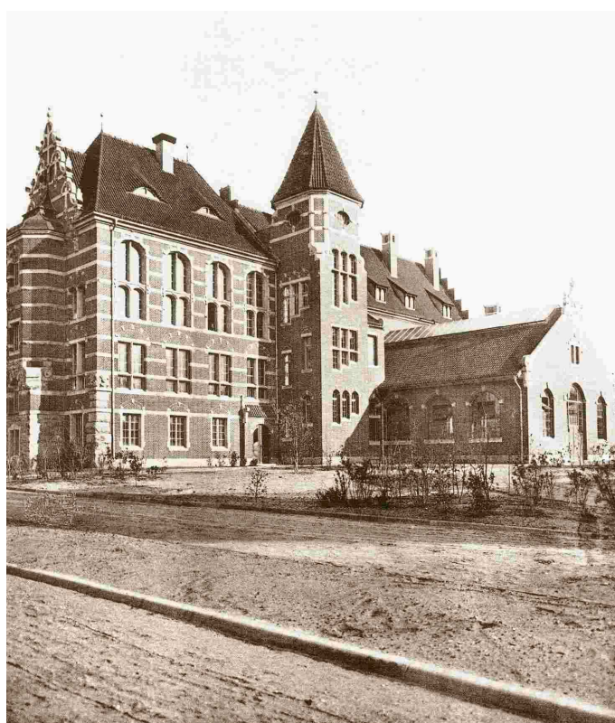
Gmach Instytutu Elektrotechnicznego w 1904 roku (część tylna)
