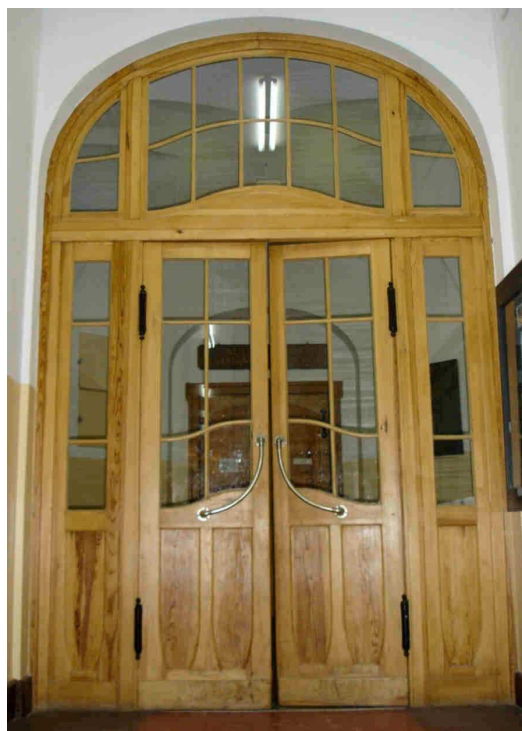
Duże dwuskrzydłowe drzwi z naświetlem i bocznymi doświetleniami, znajdujące się między korytarzem na podwyższonym piętrze a sienią; zamiast klamek zastosowano metalowe, ozdobne chwytniki
