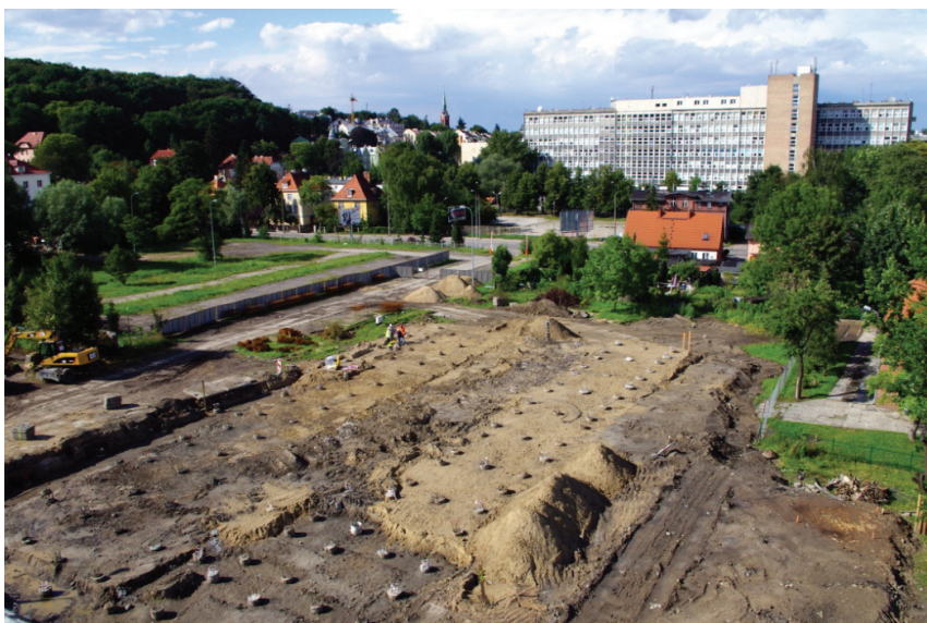
Początkowe fazy budowy, 8 sierpnia 2011 r.
