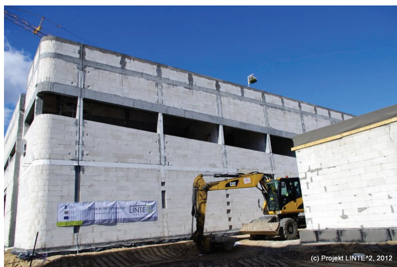
Wygląd budynku 23 marca 2012 r.
