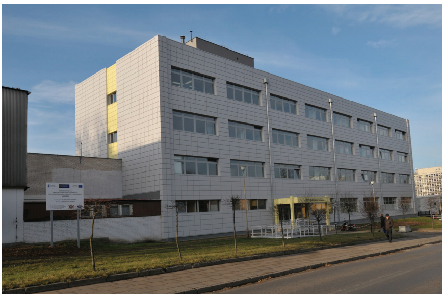
Budynek przy ul. Sobieskiego 7
