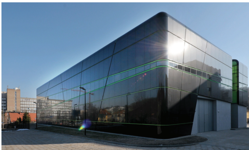
Widok budynku od strony południowo-zachodniej
