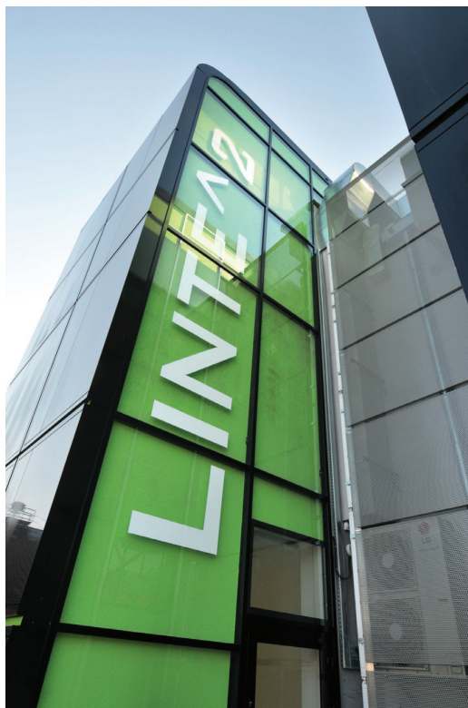
Fragment elewacji północnej budynku
