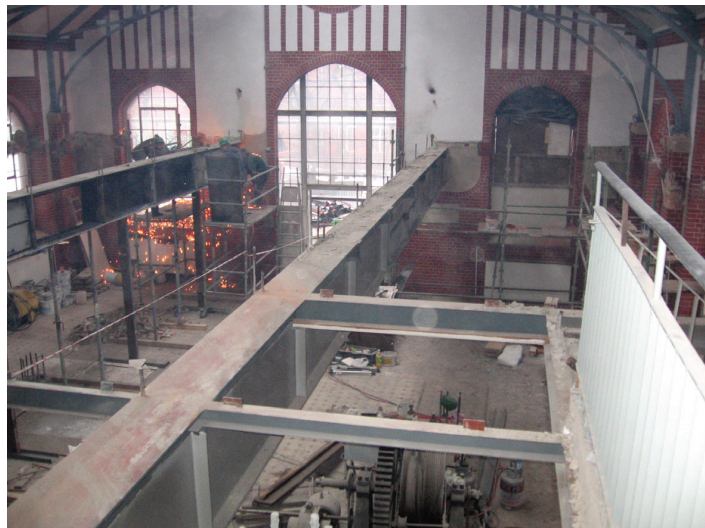
Demontaż wyposażenia i antresoli w Laboratorium Napędu Elektrycznego, 26.02.2007 r.
