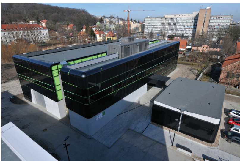
Widok budynku od strony południowo-wschodniej
