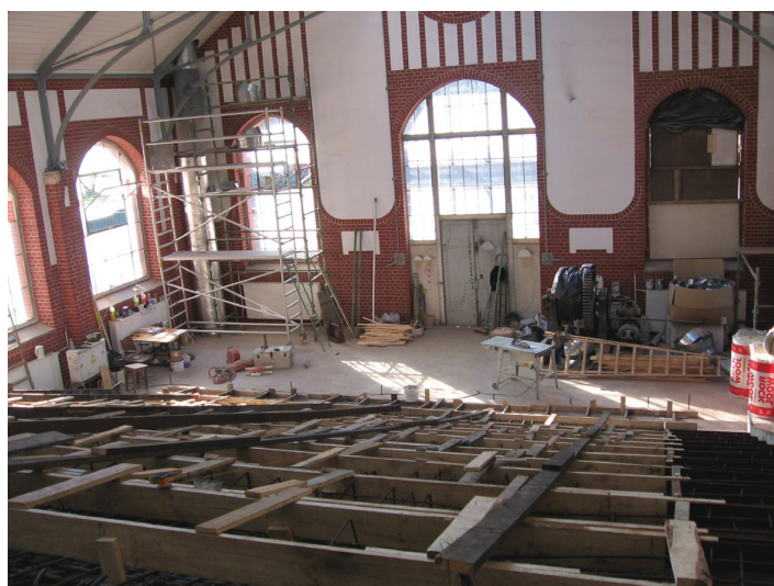
Prace budowlane w audytorium E-1, 14.04.2007 r.
