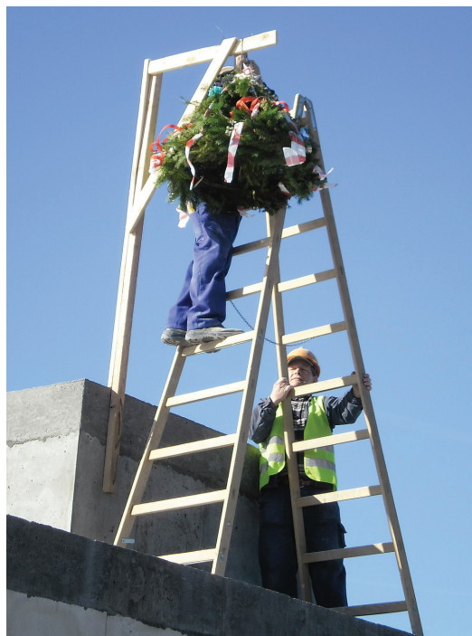
Wiecha na budynku laboratorium LINTE^2
