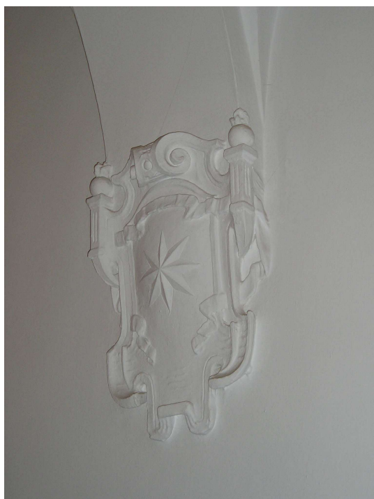
11. Tarcza herbowa umieszczone na bocznej ścianie klatki schodowej sieni
