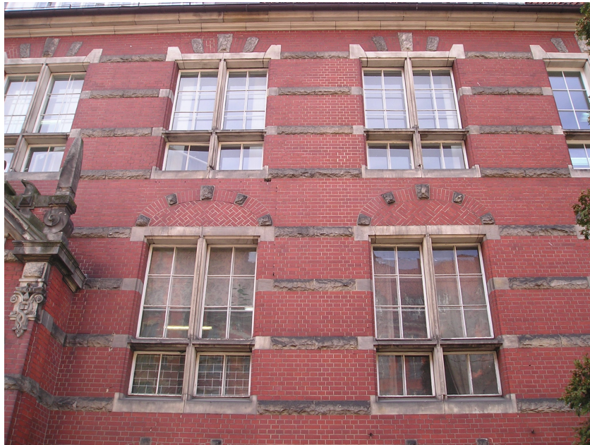
9. Elewacja południowo-wschodnia - okna sal I piętra
