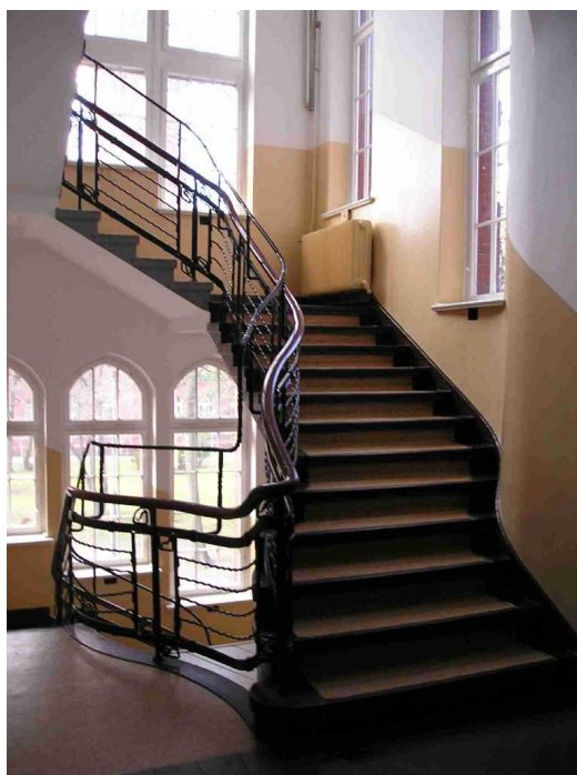
6. Gmach Wydziału Elektrotechniki i Automatyki – część 3. Widok na stopnie i metalową balustradę klatki schodowej. Stan z 2004 roku.
