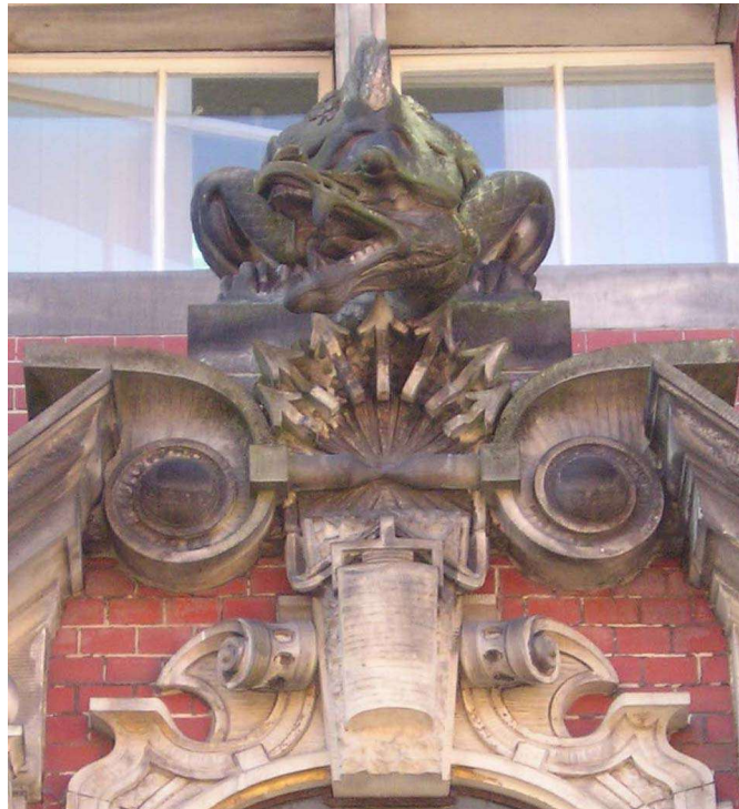
3. Ściana południowo-wschodnia – portal – urządzenie elektryczne umieszczone poniżej smoka
