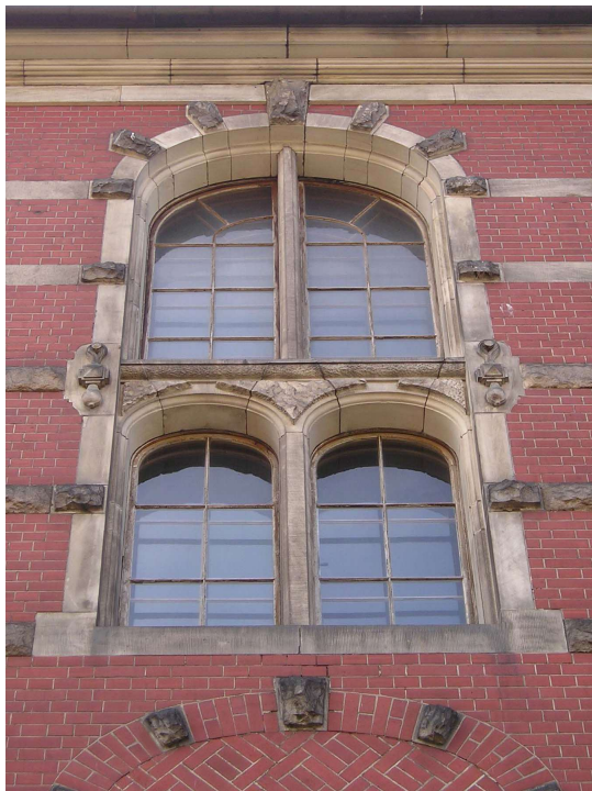
8. Okno sali audytornej w elewacji południowo-wschodniej
