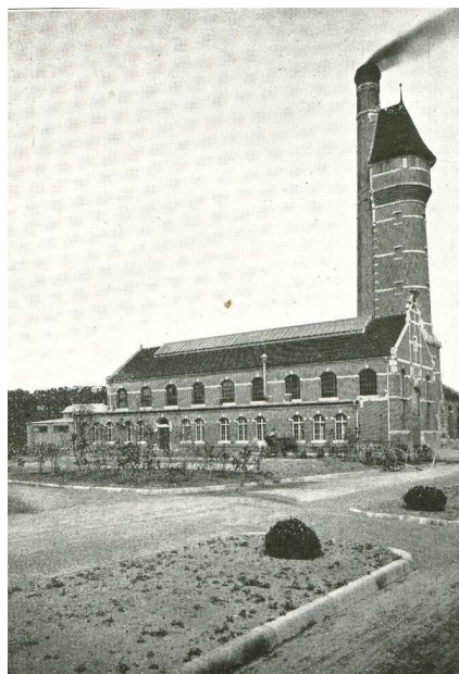
Budynek Laboratorium Maszynowego
