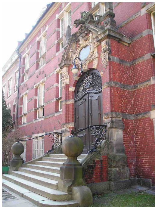
3. Gmach Wydziału Elektrotechniki i Automatyki - widok na główny portal. Stan z 2004 roku.
