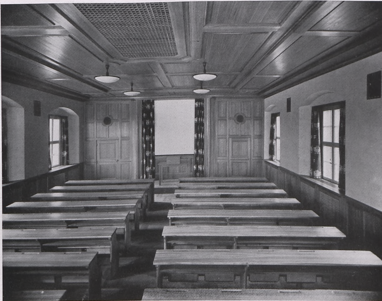
STEINENHAUSEN »HÖRSAAL« DECKE, WÄNDE UND BANKE AUS HELLGEBOHNTEM RÜSTERNHOLZ
