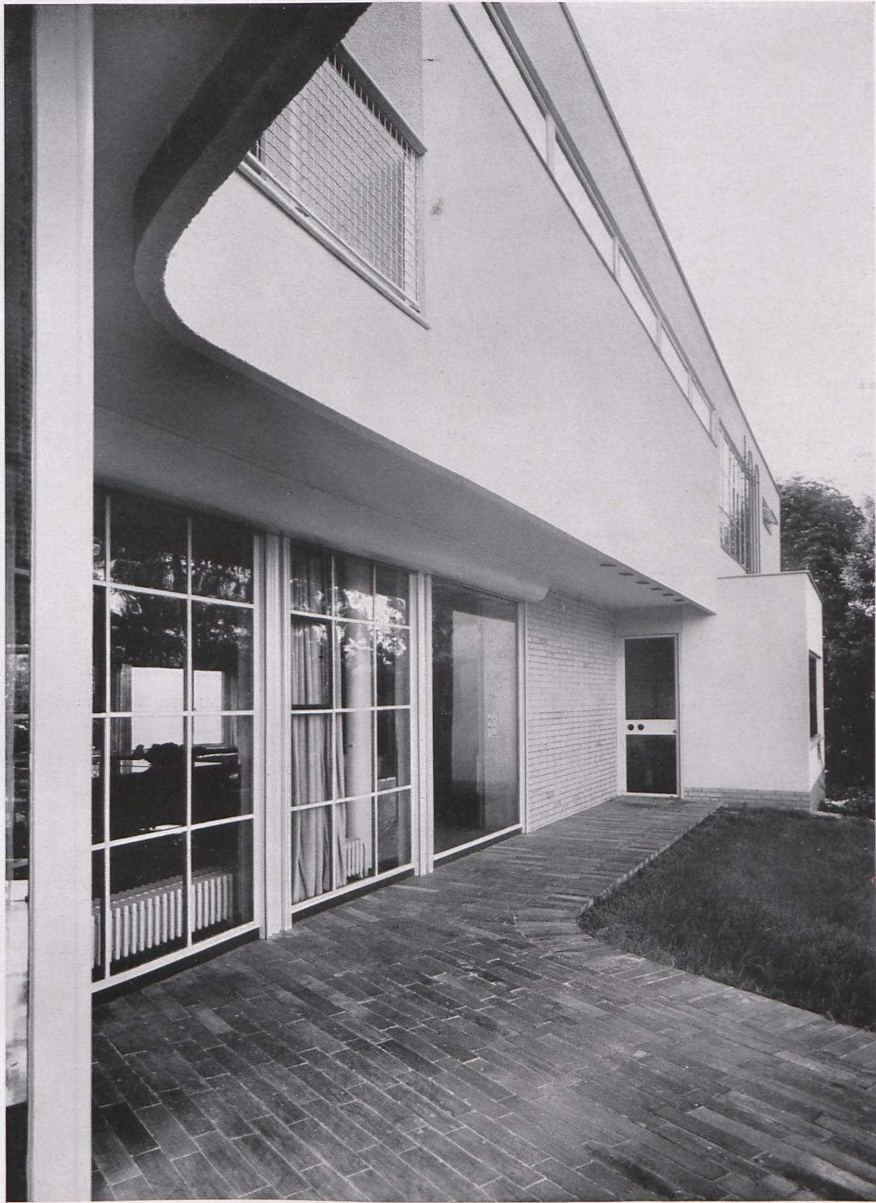
BLICK VOM WINTERGARTEN ZUM DIELEN-EINGANG DER GARTENSEITE
