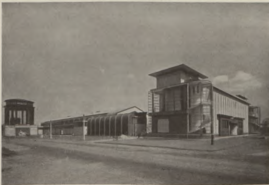
WALTER GROPIUS, BUREAUGEBÄUDE UND FABRIK
