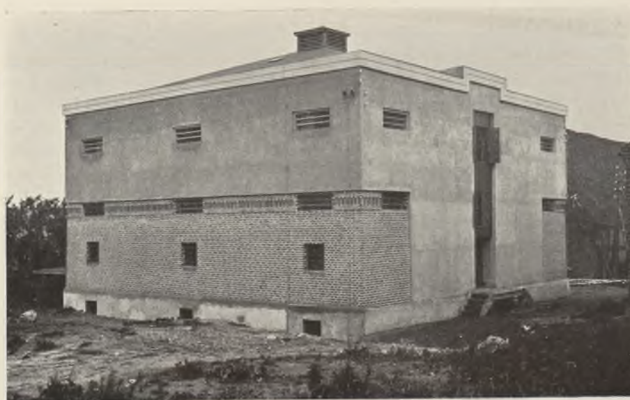
PAUL TIERSCH, KORNSPEICHER
