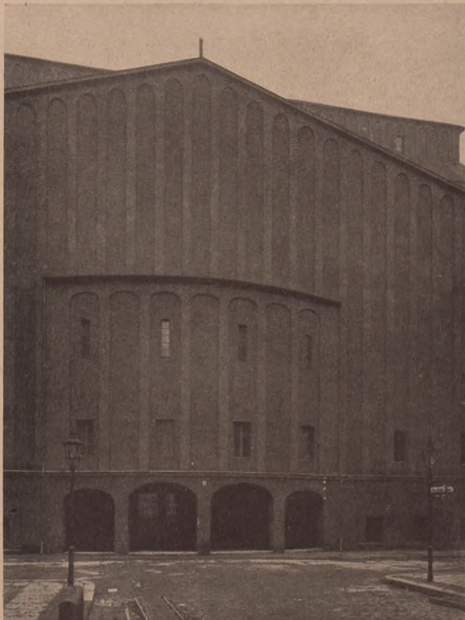
HANS POELZIG, GROSSES SCHAUSPIELHAUS. GIEBEL NACH DEM SCHIFFBAUERDAMM PHOTOGR. FOLRWANG-VERLAG, HAGEN
