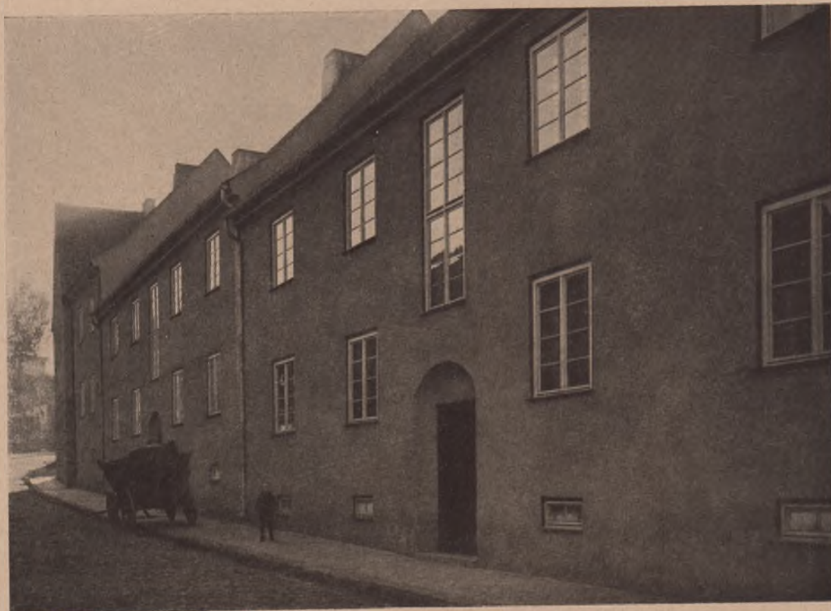
GOLDAP, KLEINHAUSBAUTEN. ARCHITEKT: FRITZ SCHOPOHL
