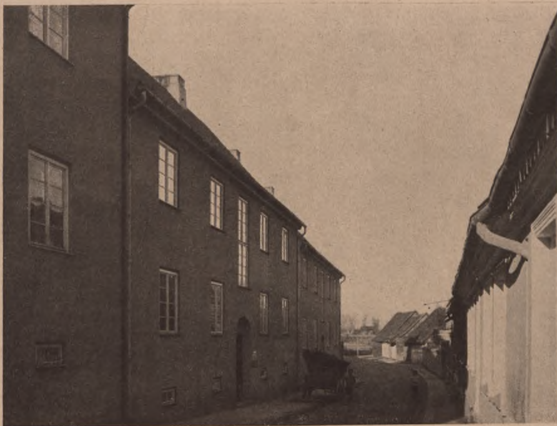
GOLDAP, KLEINHAUSBAUTEN. ARCHITEKT: FRITZ SCHOPOHL
