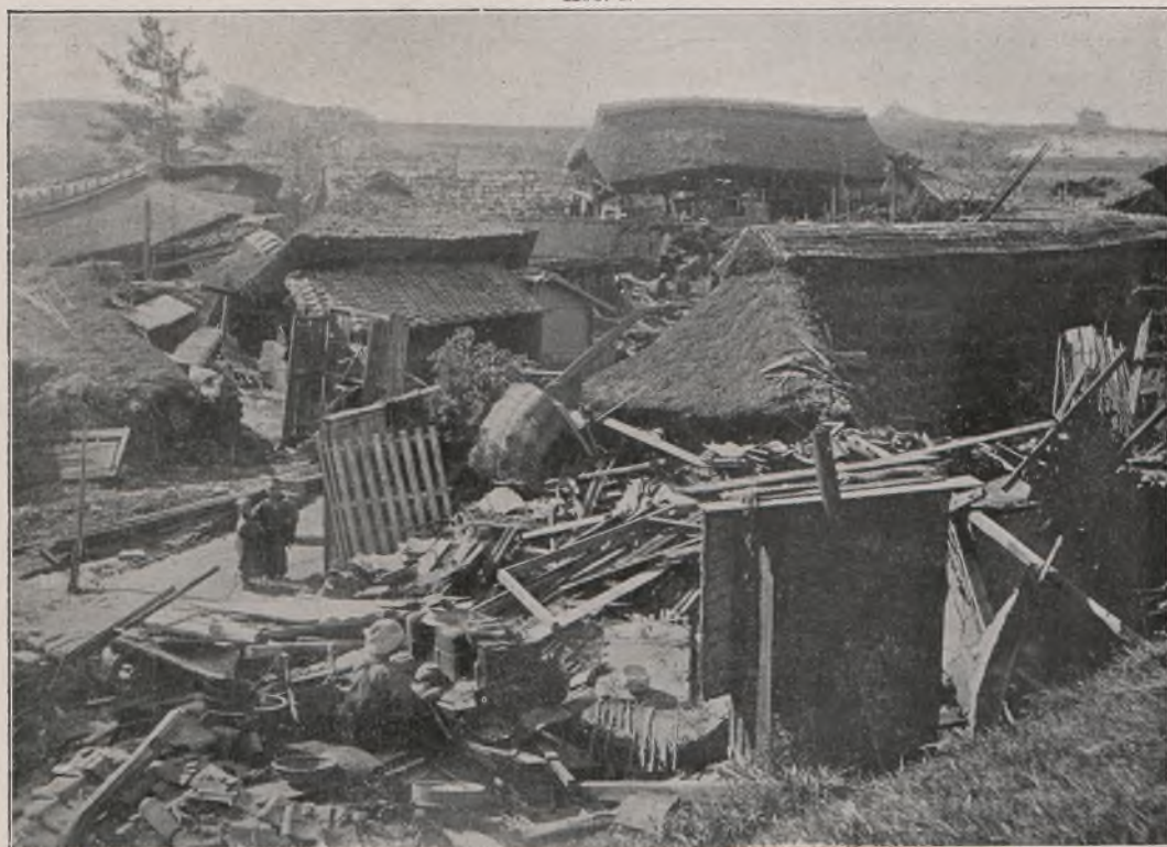
Erdbeben in Zentral-Japan, 1891 Oktober. Zerstörung der Gebäude.
