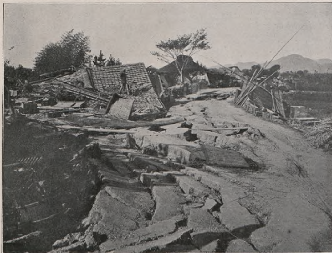
Erdbeben in Zentral-Japan, 1891 Oktober. Hauptherd der Zerstörung. Schollenförmiges Zerbrecen des Alluvialbodens.
