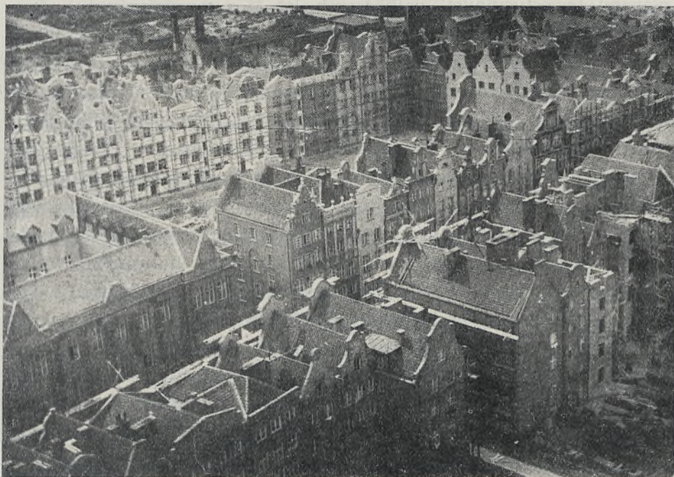
Gdańsk — widok na nowoodbudowaną dzielnicę
