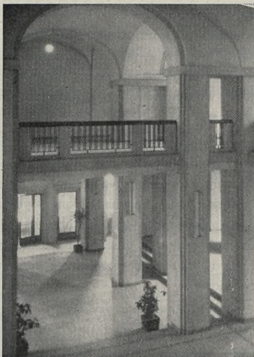
Hall Politechniki po odbudowie
