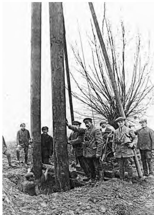
Fot. 1. Budowa linii elektrycznej; drugi od prawej Kazimierz Bieliński
