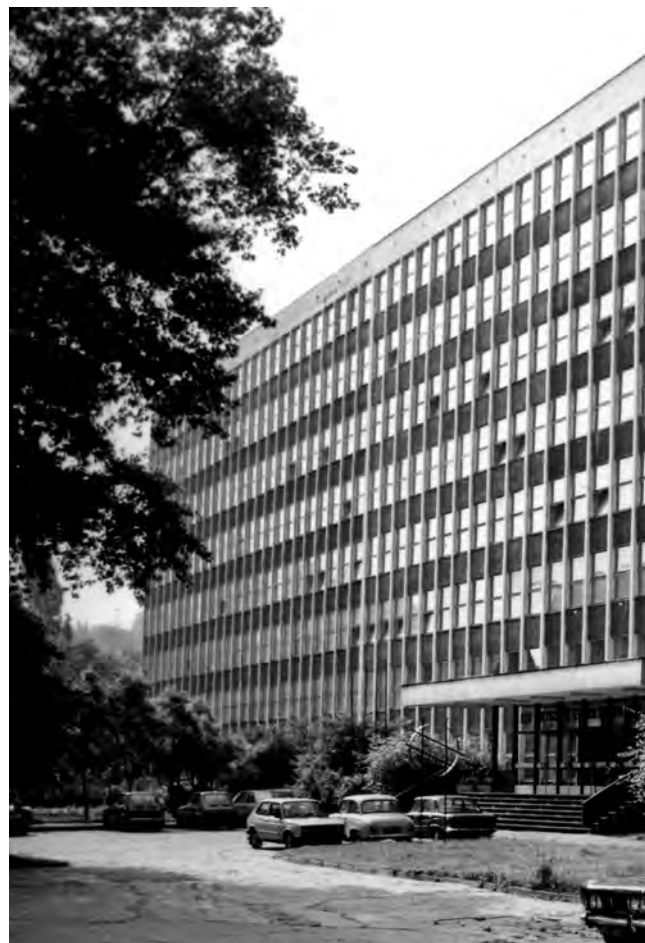
Budynek Elektroniki od roku 1972
