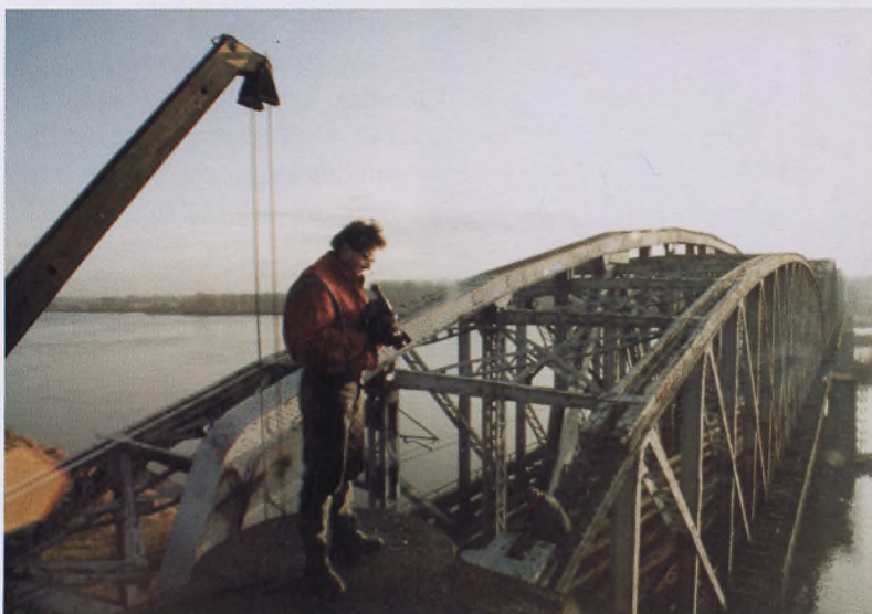
Badania mostu kolejowego przez Wisłę w Toruniu prowadzone przez Zespół Badań Terenowych Katedry Mostów
