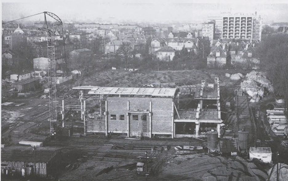
Budowa budynku Wydziału Budowy Okrętów - 1970 r.
