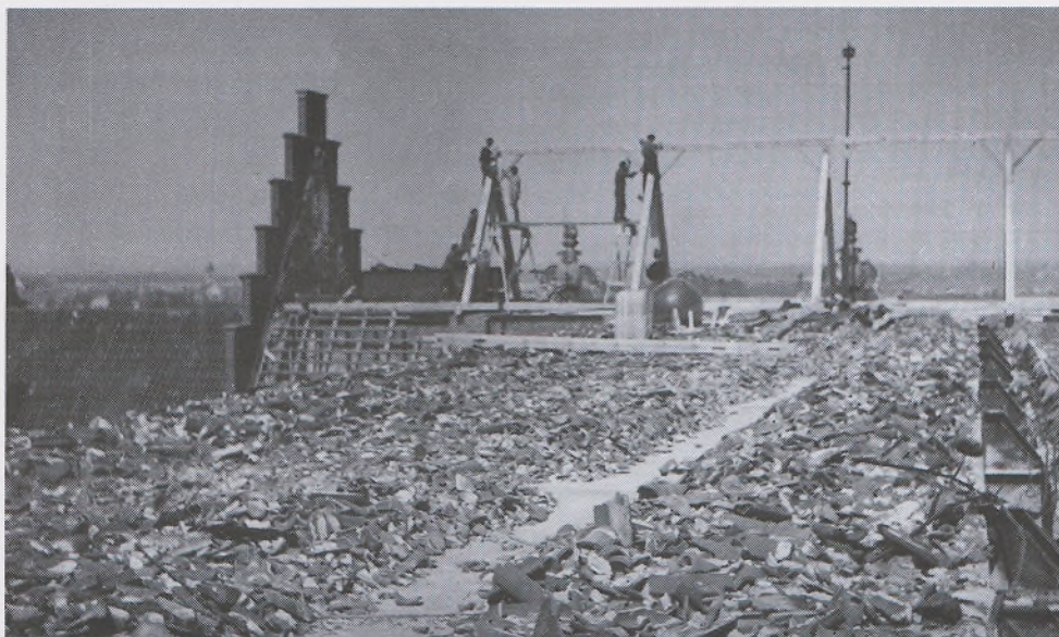
Początek odbudowy dachu nad Gmachem Głównym
