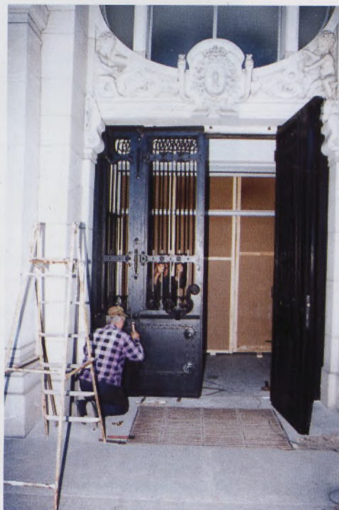
Renowacja drzwi wejściowych do Gmachu Głównego
