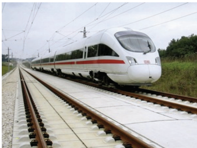
Rys. 4.26. Nawierzchnia typu Bögl na nowej linii Nürnberg–Ingolstadt [9]
