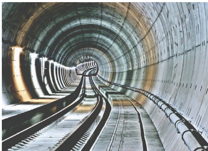
Rys. 4.30. Nawierzchnia typu ÖBB-PORR zastosowana w tunelu [13]
