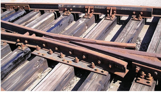
Rys. 5.17. Krzyżownica z wkładką ze stali manganowej [4]
