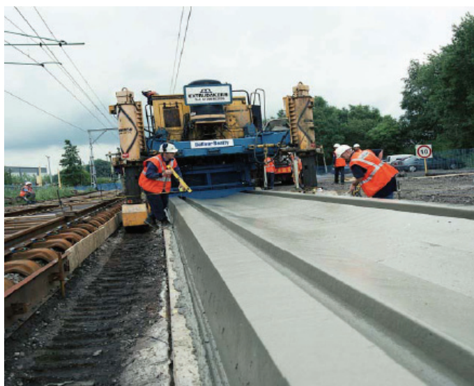
Rys. 4.44. Wylewanie płyty betonowej na mokro w technologii BBEST [20]
