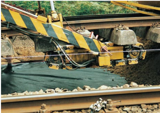
Rys. 10.38. Schemat maszyny SVV100 oraz widok układanego wzmocnienia [6]
