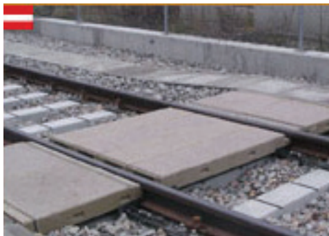
Rys. 6.11. System płyt U-BODAN [4]
