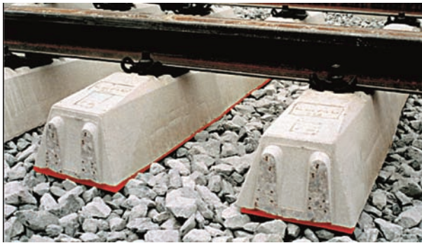
Rys. 3.50. Podkłady strunobetonowe powlekane od spodu warstwą tworzywa plastycznie odkształcalnego (na zdjęciu w kolorze czerwonym) [16]
