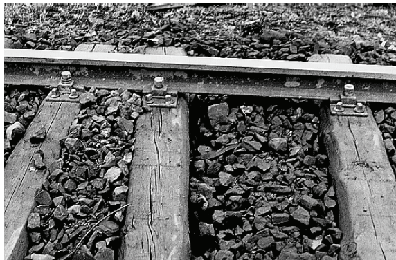
Rys. 10.20. Skoszenie podkładów w wyniku pelzania szyn [1]
