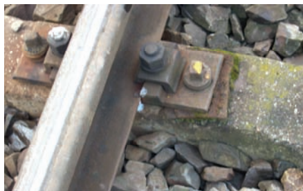
Rys. 10.25. Uszkodzona i wysunięta przekładka pod podkładką żebrową
