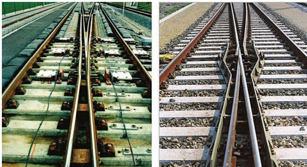
Rys. 5.21. Krzyżownice z ruchomym dziobem produkcji Voestalpine [9]
