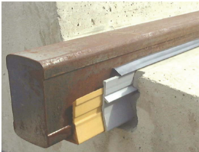
Rys. 4.42. Ułożenie szyny w kanałach płyty betonowej BBEST
