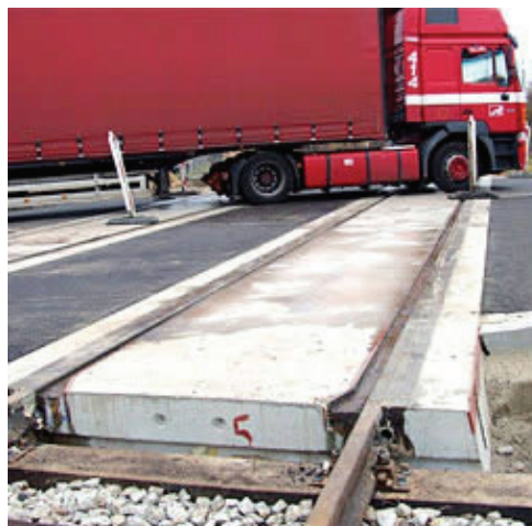
Rys. 6.20. System Edilon LC-L [8]: a) Leszno, woj. wielkopolskie – linia nr 817, ciąg drogi krajowej nr 5; b) Kraków – linia nr 100, ciąg ul. Władysława Łokietka
