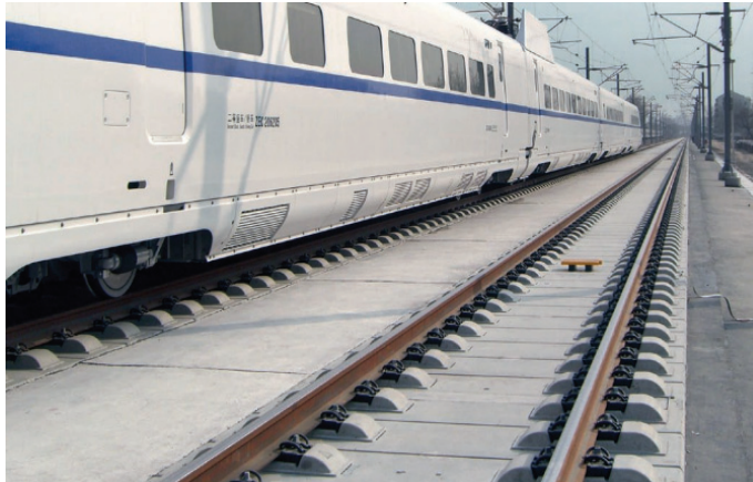
Rys. 9.17. Płyta z betonu w technologii Bögl zastosowana w Chinach [2]
