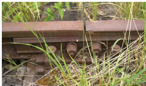
Rys. 10.26. Brak śruby łubkowej
