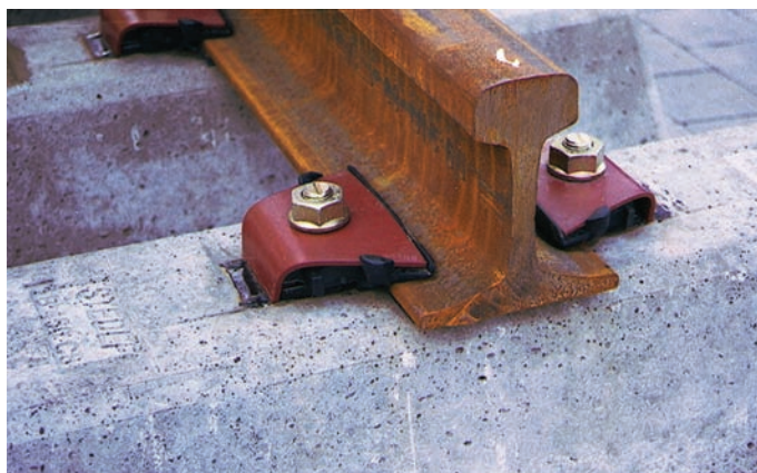
Rys. 9.12. Przytwierdzenie Nabla (Francja)
