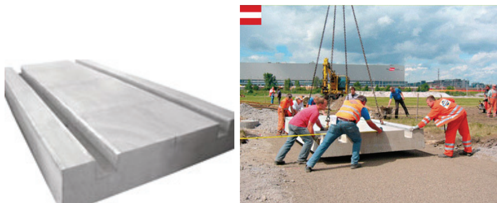
Rys. 6.23. System płyt BODAN BO-TRACK [4]
