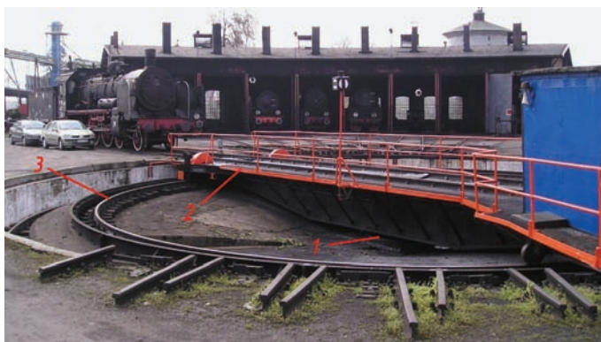
Rys. 5.1. Obrotnica. 1 – czop królewski; 2 – obrotowy pomost; 3 – szyna obwodowa [4]
