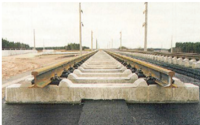
Rys. 4.45. Układanie nawierzchni ATD na linii kolejowej Hanower–Berlin [18]
