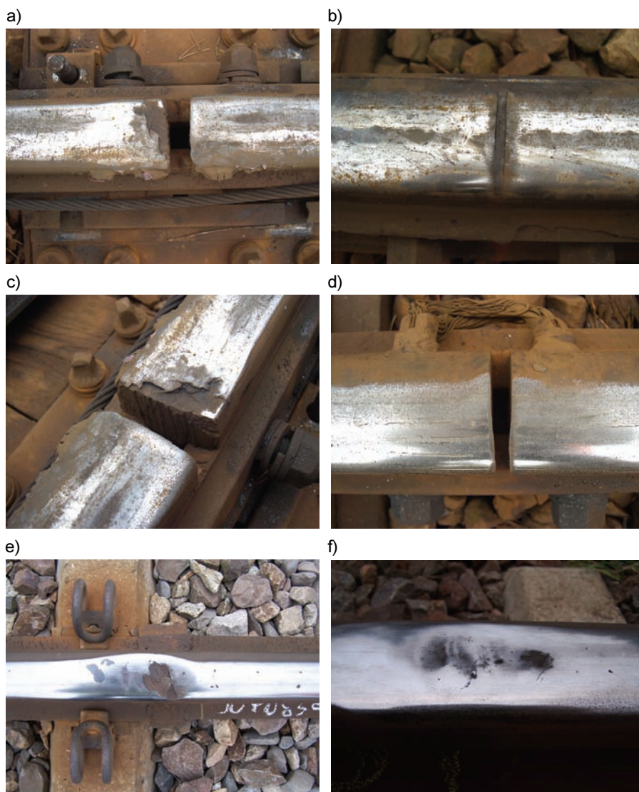
Rys. 10.15. Uszkodzenia powierzchni tocznej szyny w obrębie styku
