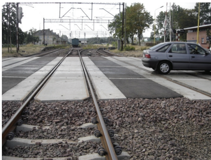
Rys. 6.17. Przejazd o nawierzchni CBP [8]
