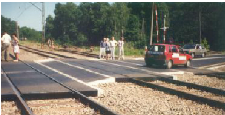
Rys. 6.24. Przejazd z płyt KOL-DROG [12]
