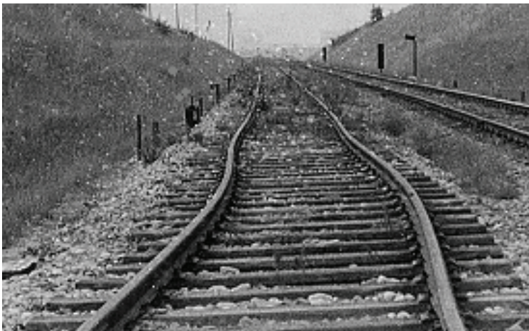
Rys. 10.28. Wybożenie toru [1]
