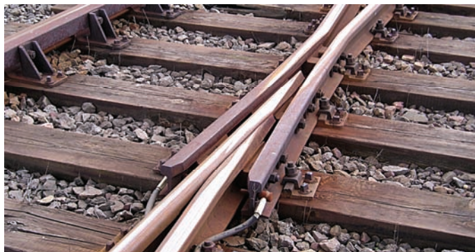
Rys. 5.16. Krzyżownica szynowa z dziobem z szyn zwykłych [4]
