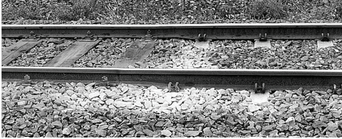
Rys. 10.23. Pierwsze objawy powstawania wychłapek [1]
