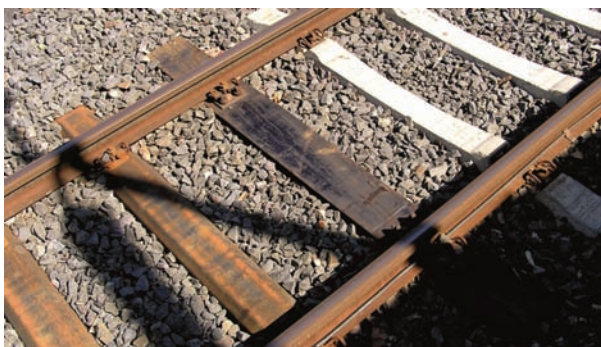
Rys. 3.35. Podkłady kolejowe [16]
