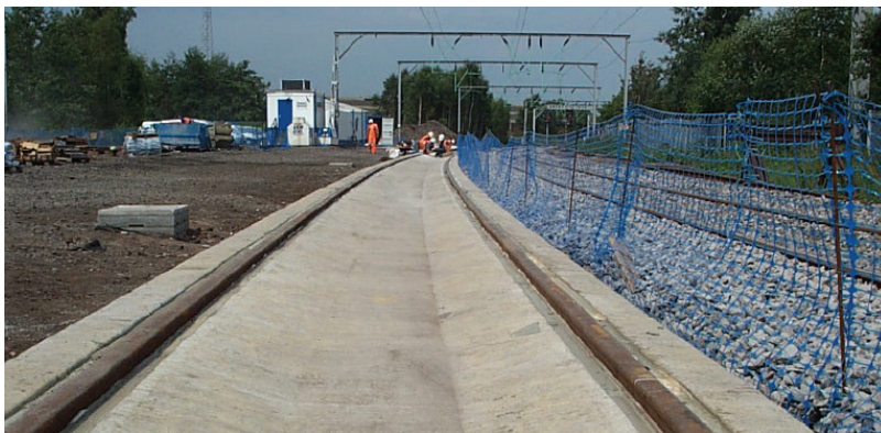
Rys. 4.40. Tor kolejowy zbudowany w technologii BBEST na linii Crewe–Kidsgrove (Wielka Brytania) [4]
