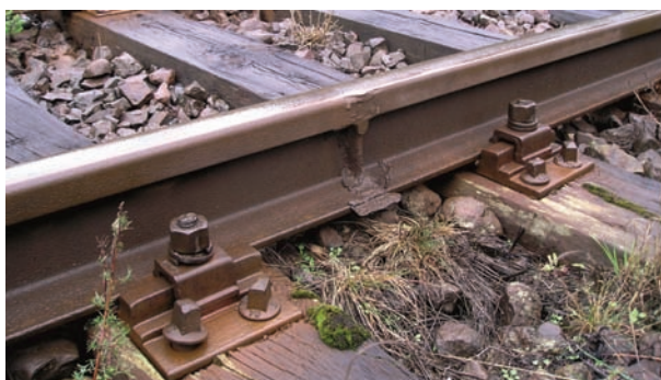
Rys. 3.32. Złącze spawane (spaw termitowy) szyn 49E1 [9]
