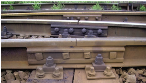
Rys. 3.30. Złącze podparte izolowane szyn 60E1 (na pierwszym planie) [9]
