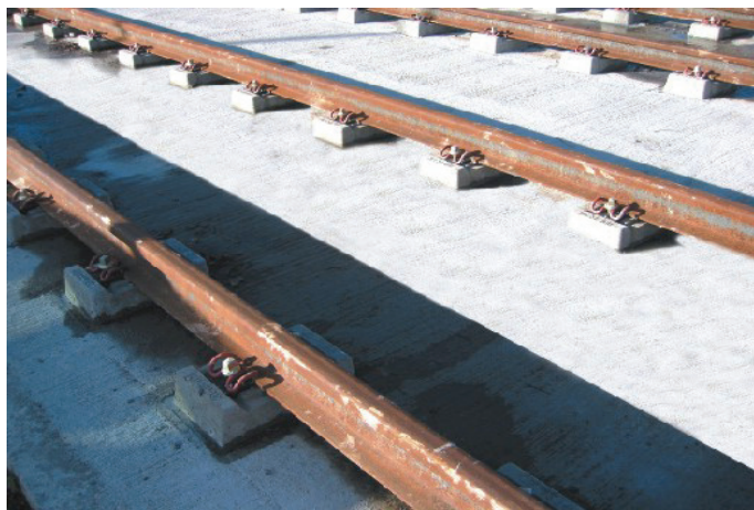
Rys. 9.16. Nawierzchnia systemu podpór blokowych EBS
