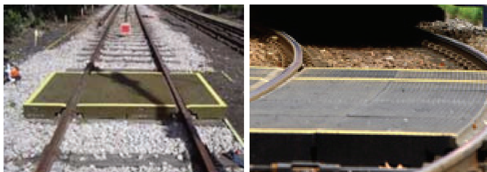
Rys. 6.32. Nawierzchnia z płyt gumowych typu HOLDFAST na przejściach służbowych [6]
