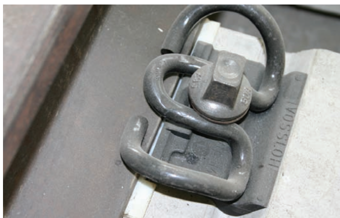
Rys. 9.11. Przytwierdzenie Vossloh (Niemcy)
