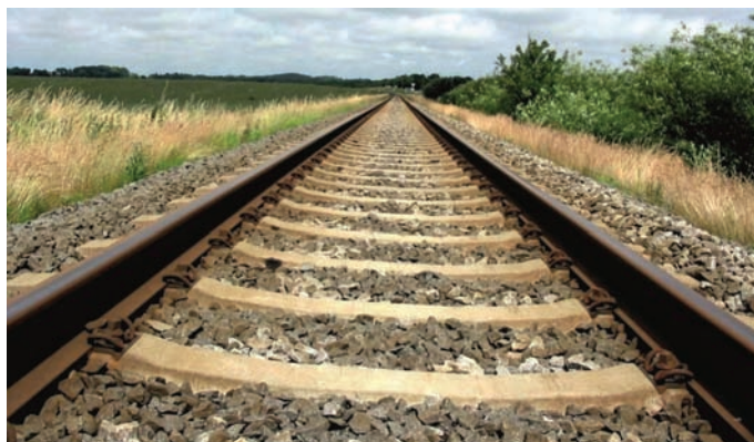
Rys. 3.2. Nawierzchnia kolejowa wykonana z szyn szerokostopowych ułożonych na podkładach betonowych i podsypce tłuczniowej [16]
