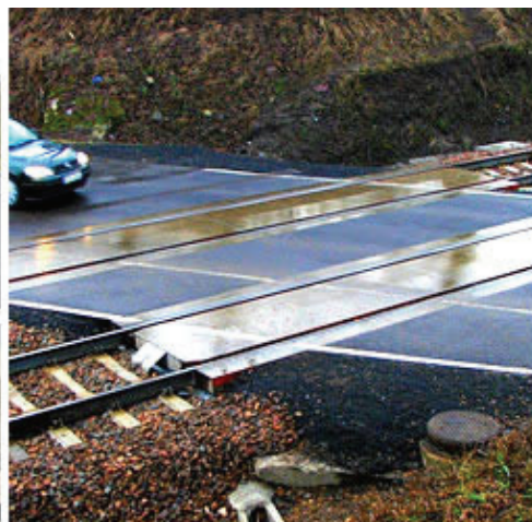
Rys. 6.20. System Edilon LC-L [8]: a) Leszno, woj. wielkopolskie – linia nr 817, ciąg drogi krajowej nr 5; b) Kraków – linia nr 100, ciąg ul. Władysława Łokietka
