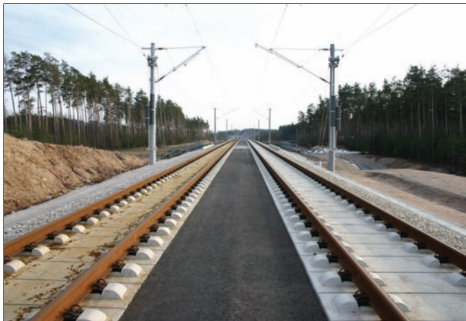
Rys. 9.14. Linia Norymberga–Ingolstadt z nawierzchnią bezpodsypkową [1]
