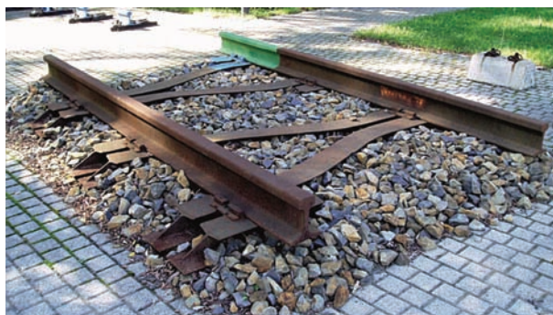
Rys. 3.51. Tor na podkładach stalowych typu Ypsilon [17]
