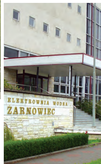
Fot. 1. Wejście do budynku elektrowni
