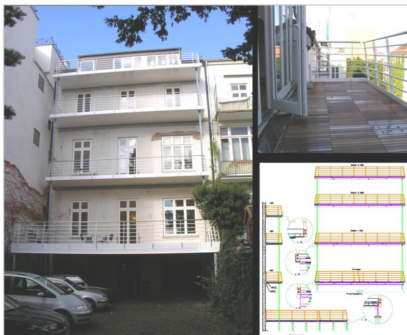
Rys.2.23 Balkony dostawiane do budynków [45]
