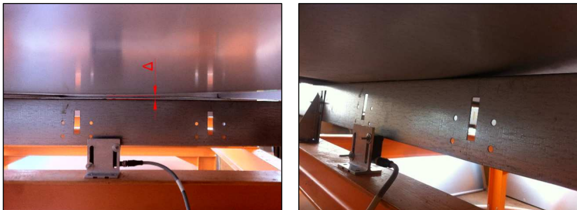
Rys. 46. Ugięcia powierzchni lica kasetonu o wymiarach 2030 x 888 mm przy obciążeniu parciem wiatru. Po lewej: przed oparciem, po prawej: po oparciu się o systemowy ruszt. Fot. P. Lewandowski.
