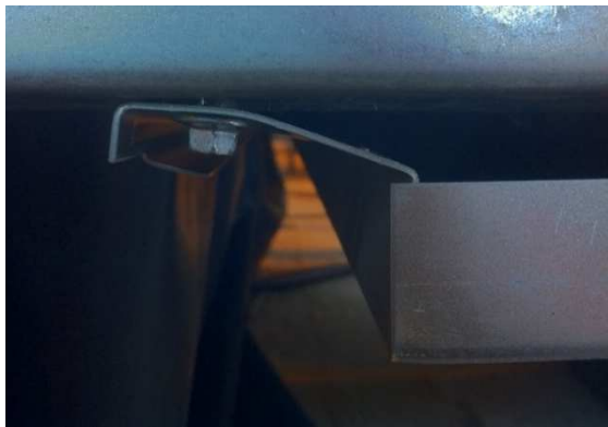
Rys. 65. Porównanie rzeczywistych deformacji kasetonu z modelem komputerowym pod obciążeniem ssaniem wiatru.
