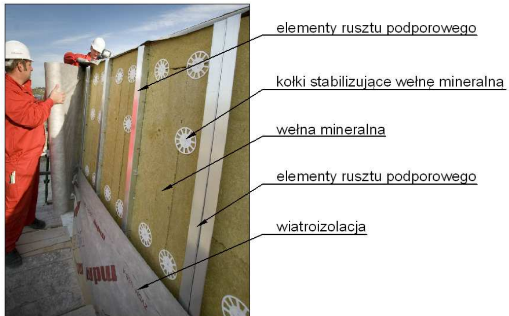
Rys. 11. Elementy części wewnętrznej izolacji. Widoczny ruszt podporowy, izolacja z wełny mineralnej oraz folia wiatroizolacji. Fot. materiały firmy Balexmetal.
