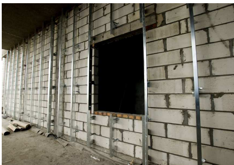
Rys. 14. Ruszt podporowy przytwierdzony do ściany nośnej, gotowy do montażu warstwy ocieplenia, wiatroizolacji oraz kasetonów elewacyjnych. Fot. materiały firmy Balxmetal.
