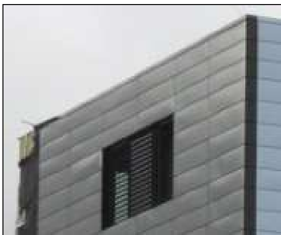
Rys. 1. Lewa strona: Widoczne zaburzenia płaskości elewacji powstałe podczas montażu okładziny elewacyjnej. Prawa strona: Poprawnie wykonana elewacja z idealnym odbiciem światła. Fot. Piotr Lewandowski.
