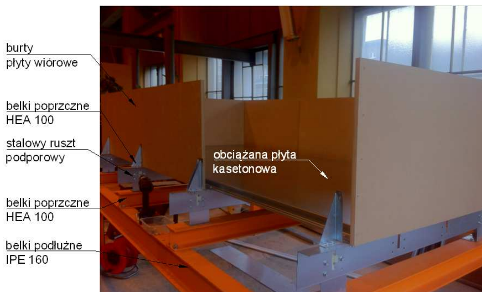
Rys. 30. Zdjęcie montażu szalunku pod obciążenie wodą, symulujące parcie wiatru na powierzchnię kasetonu. Fot. P. Lewandowski.
