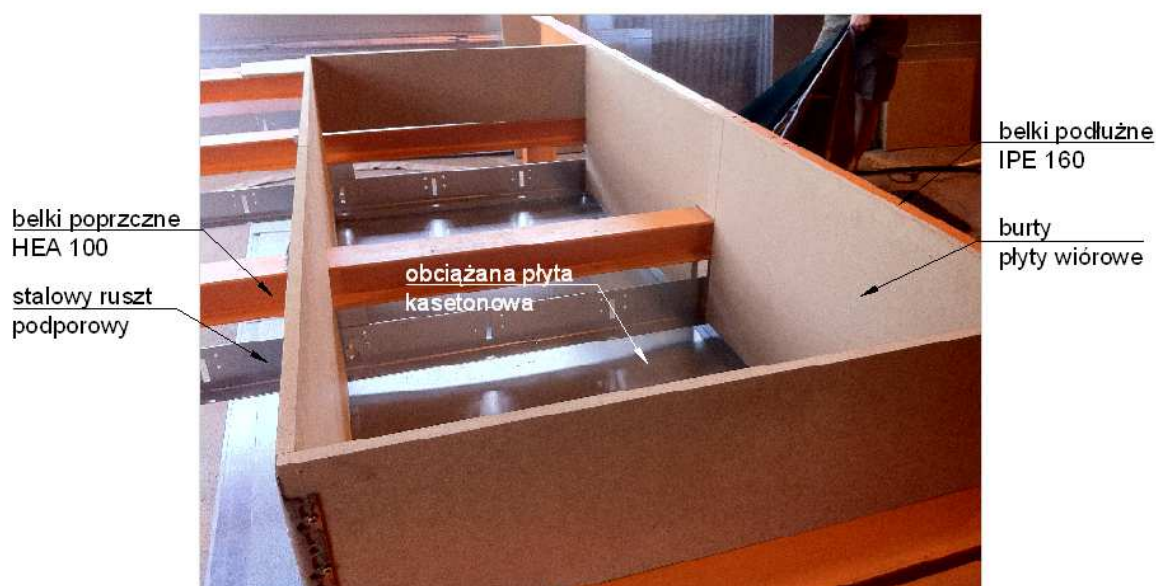
Rys. 31. Widok kasetonu podwieszanego do konstrukcji nośnej stanowiska badawczego w celu umożliwienia obciążania wodą symulującego ssanie wiatru. Fot. P. Lewandowski.
