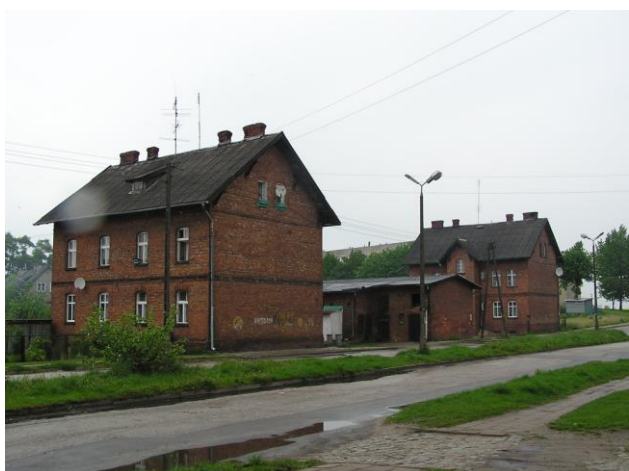
zdj. 12. Pelplin. Zespół zabudowy przy dworcu kolejowym, fot. E. Stieler
