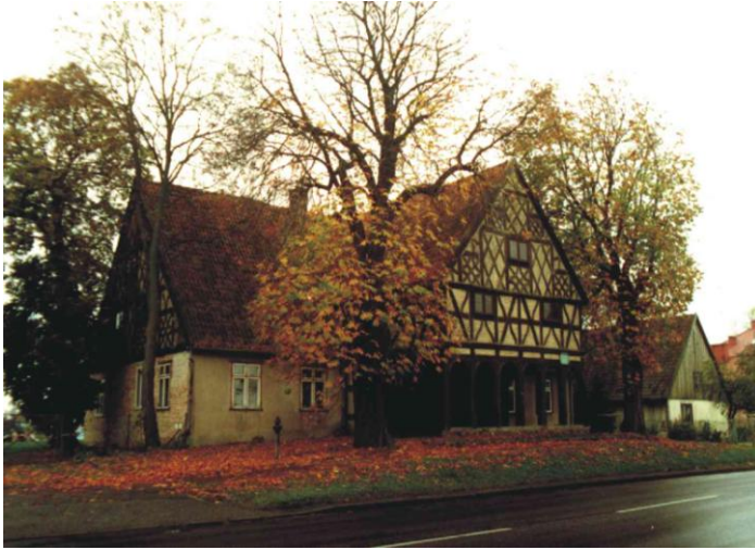
zdj. 8. Koszwały 44 (gmina Cedry Wielkie) dom podcieniowy z 1792r. (fot. J. Poczobut 2001r.)
