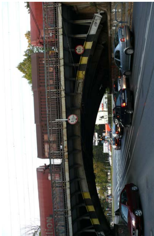
Ryc. III.38. Konflikty ograniczeń technicznych: zaniżona skrajnia wiaduktu (po lewej) lub ograniczona nośność wiaduktu (po prawej). Zdjęcia: R. Okraszczyńska
