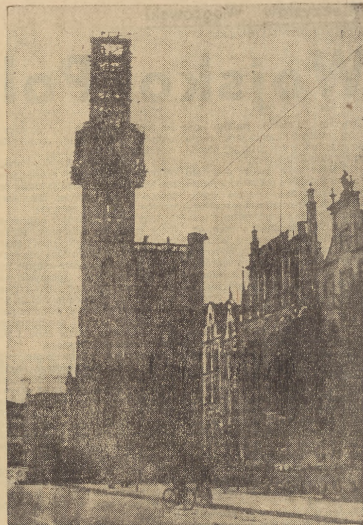
Odbudowa gdańskiego Ratusza postępuje naprzód. Robotnicy PPB Nr. 3 montują konstrukcję żelazną wczm, która wraz z figurą Zygmunta będzie wysoka 34 mtr 45 cm. Cała wieża wraz z chełmem sięga 80 mtr.
