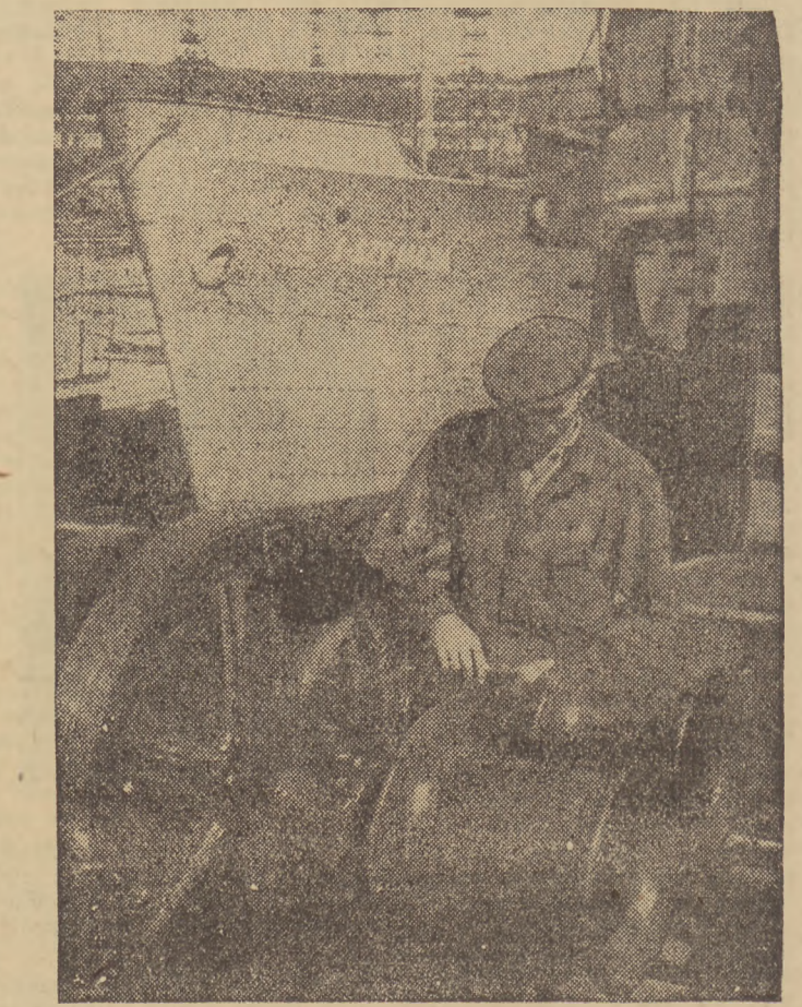
Na pokładzie s/s „Soldek” znajduje się kilka wind. Na zdjęciu Marian Szczepański montuje ostateczną windę na dźwigie statku. Na drugim planie s/s „Pierwsza Mała”
