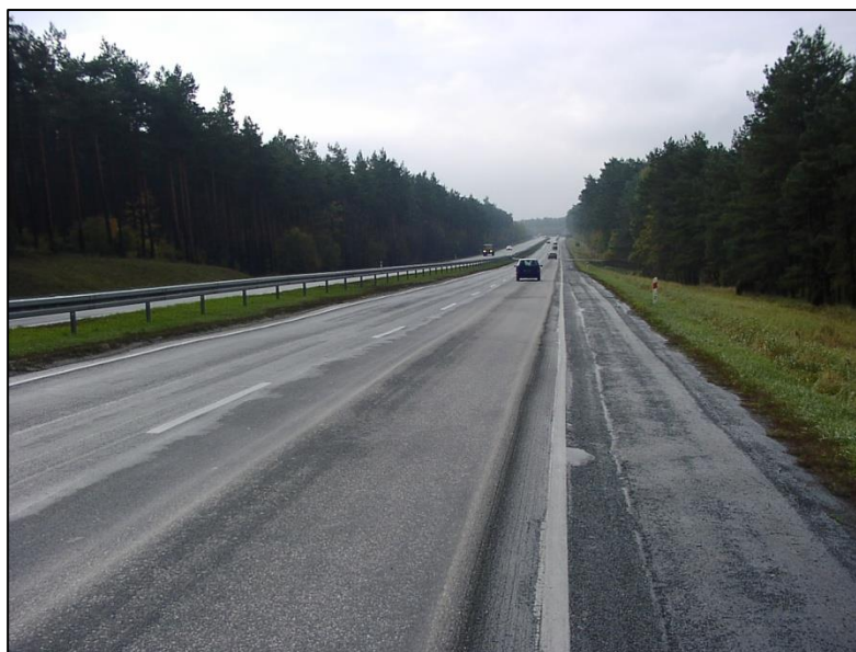
Rysunek 2.10. Trwałe deformacje nawierzchni (koleiny) [archiwum katedry]
