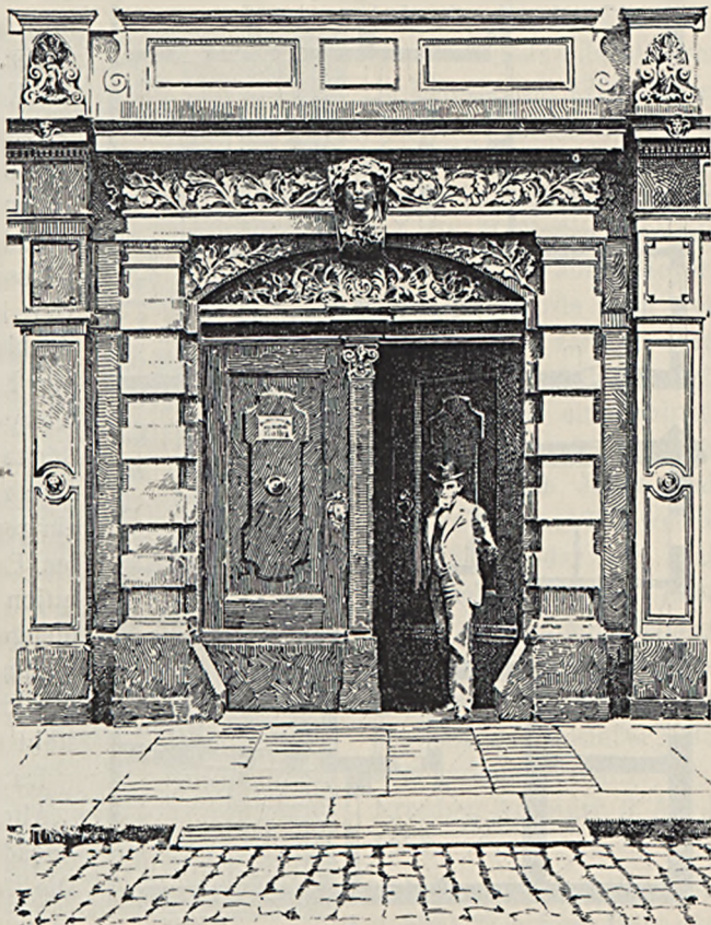
Fig. 531. Neumarkt Nr. 12. Zustand vor 1901
