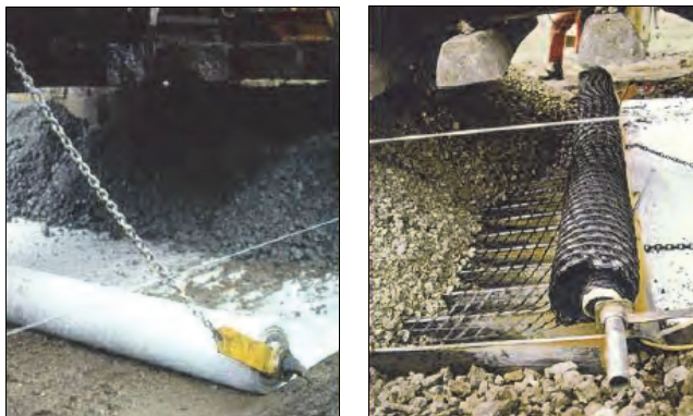
Rys. 11.44. Układanie geowłókniny i geosiatki maszyną RPM RS 900 [132]
