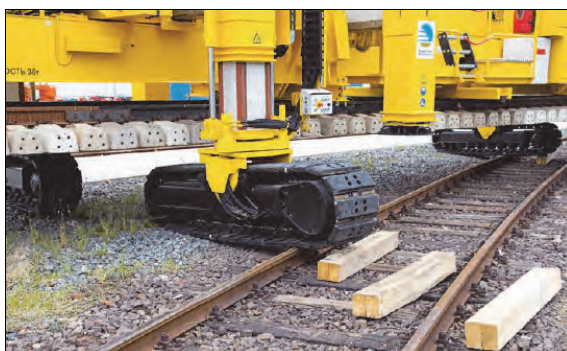
Rys. 10.33. Przejazd suwnicy DESEC TRACKLAYER przez tor [64]
