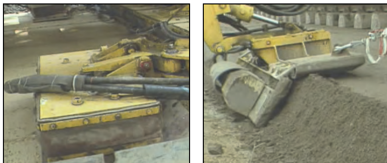
Rys. 11.27. Zagęszczanie warstwy kruszywa i ławy torowiska maszyną SVV100 [68]
