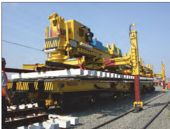
Rys. 10.37. Uniesienie rozjazdu na podnośnikach maszyną WM-40/PK [68]
