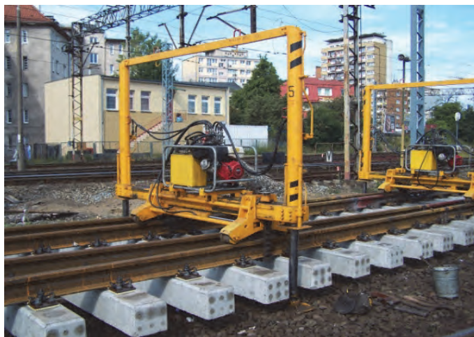
Rys. 10.24. Ułożenie nowego rozjazdu za pomocą podnośników torowych urządzenia UWR (J. Zariczny)
