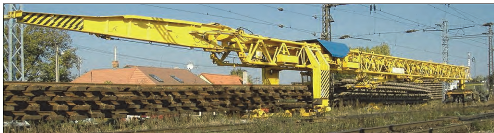
Rys. 9.34. Układanie przęseł na wózkach suwnicą PKP 25/20 [81]
