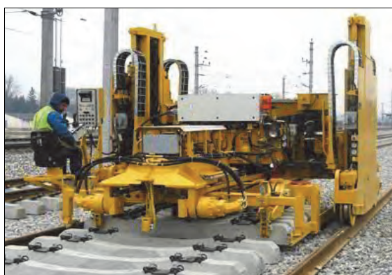
Rys. 9.46. Suwnica portalowa PA 1-20 ES firmy ROBEL [74]
