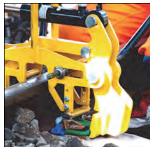
Rys. 4.16. Osprzęt do zapinania przytwierdzenia PANDROL FASTCLIP [75]
