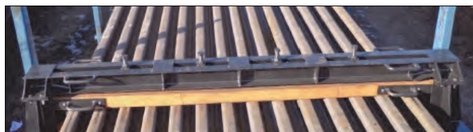
Rys. 9.3. Zabezpieczenie szyn belką poprzeczną [52]
