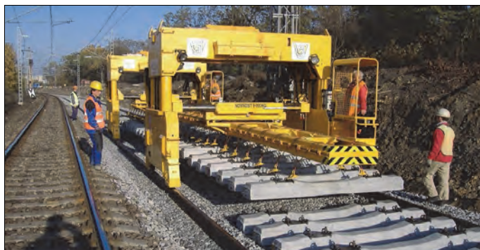
Rys. 9.45. Układanie podkładów suwnicą PTH-350 [62]
