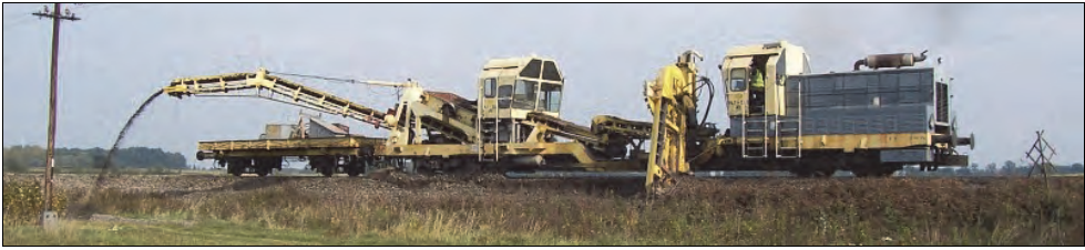
Rys. 6.18. Profilarka ław torowiska PŁT 500 (D. Krysztofiak) [148]
