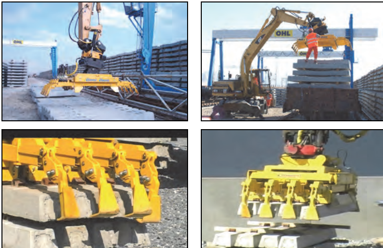
Rys. 11.21. Układacz podkładów SL 400 TRAWERS firmy Rosenqvist & Pandrol podczas załadunku i wyładunku podkładów kolejowych [75]
