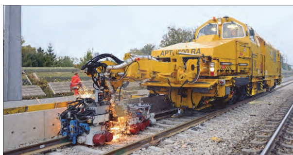
Rys. 7.11. Zgrzewarka szyn APT1500 RA [68]
