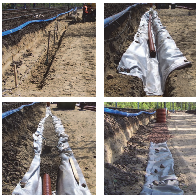
Rys. 11.15. Etapy ułożenia ciągu drenarskiego (J. Zariczny)
