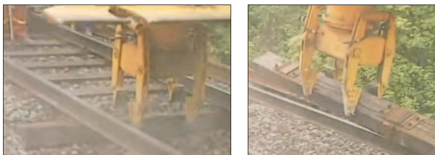
Rys. 4.18. Wyjęcie starego podkładu z toru [75]
