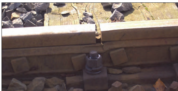
Rys. 4.37. Przesunięcie szyny w styku
