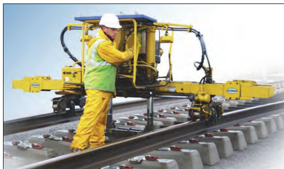
Rys. 9.48. Urządzenie do wkładania szyn MPR firmy Geismar [62]
