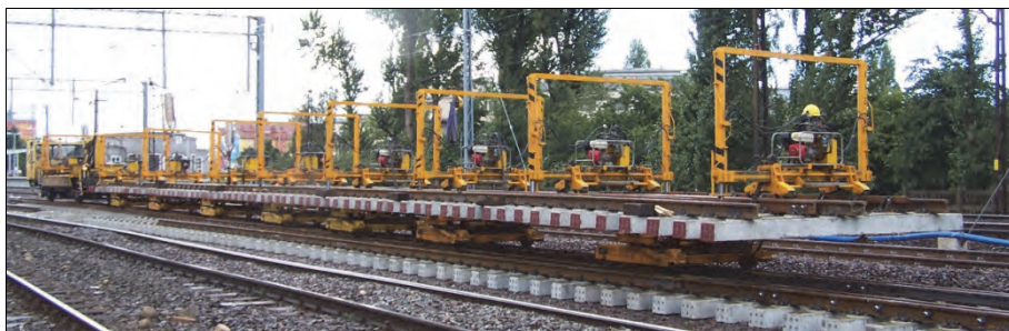
Rys. 10.20. Urządzenie do wymiany rozjazdów UWR 10 (J. Zariczny)
