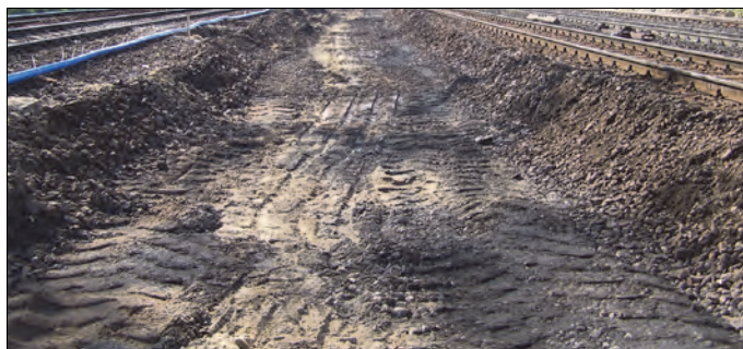
Rys. 11.13. Wybrana warstwa gruntu zmieszanego z podsypką (J. Zariczny)
