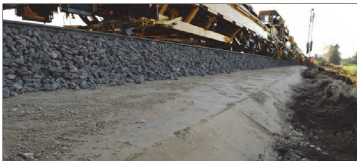
Rys. 11.45. Tor po wykonanej naprawie maszyną RPM RS 900 [145]
