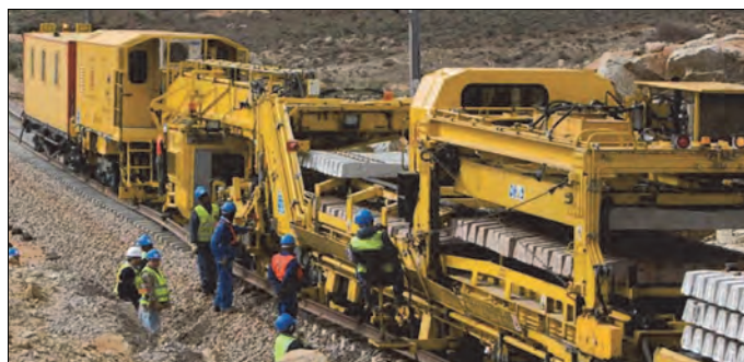
Rys. 9.80. Maszyna P 190 firmy Matisa – kontrola ułożenia podkładów [67]
