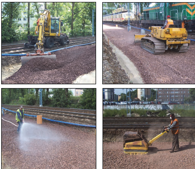
Rys. 11.20. Przemieszczanie, profilowanie i zagęszczanie warstwy ochronnej z kłińca (J. Zariczny)
