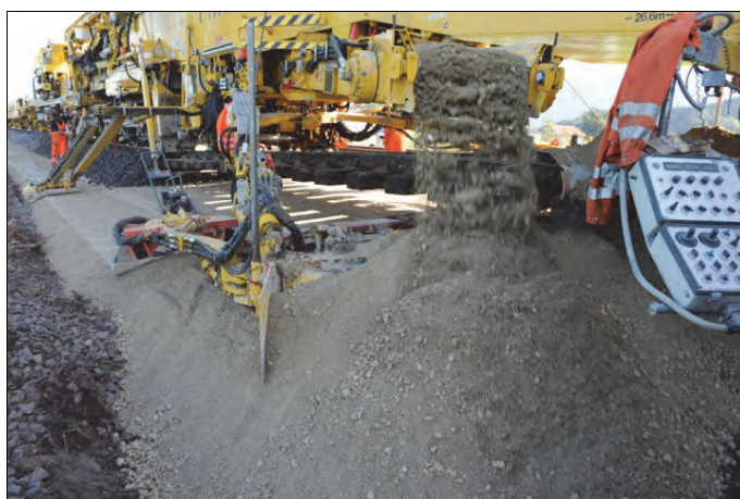
Rys. 11.43. Układanie warstwy ochronnej maszyną RPM RS 900 [68]
