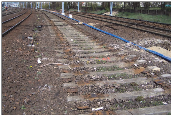
Rys. 11.6. Wyjęte szyny na długości remontowanego podtorza (J. Zariczny)
