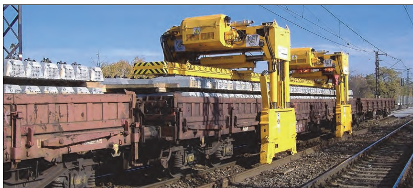
Rys. 9.44. Załadunek podkładów z wagonu platformy suwnicą PTH-350 [62]
