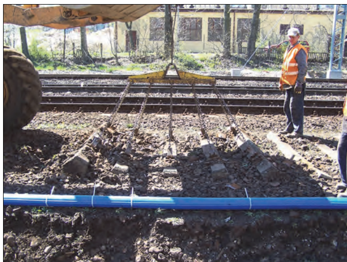
Rys. 11.7. Wyjęcie podkładów z podsypki (J. Zariczny)
