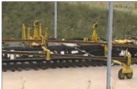
Rys. 9.12. Gniazda, przez które przesuwane są szyny w systemie firmy NEW SOREMA FERROVIARIA [78]
