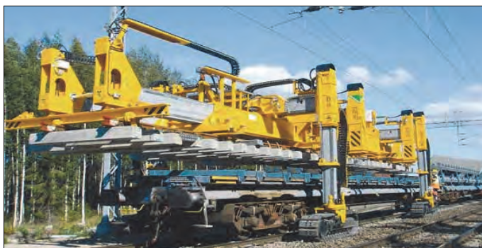
Rys. 9.39. Zdjęcie przęśla z wagonu układarką DESEC TL [64]
