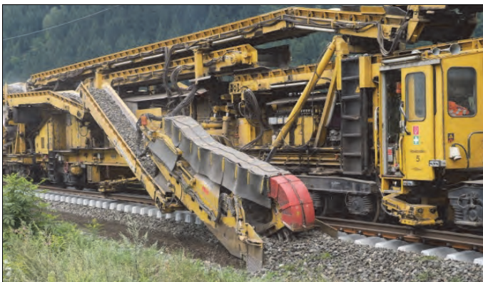
Rys. 9.93. Profilowanie i oczyszczanie podsypki od czół podkładów maszyną RU800 [68]
