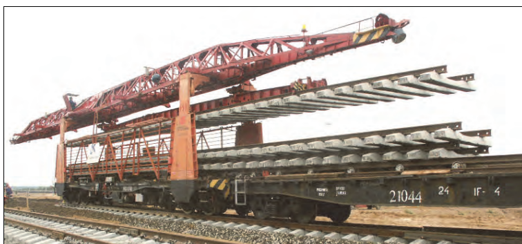
Rys. 9.32. Transport i układanie nowego przęsła żurawiem UK-25 [81]
