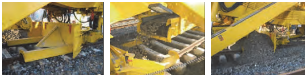
Rys. 6.15. Wsypanie oczyszczonej podsypki w tor przez oczyszczarkę firmy Matisa [67]
