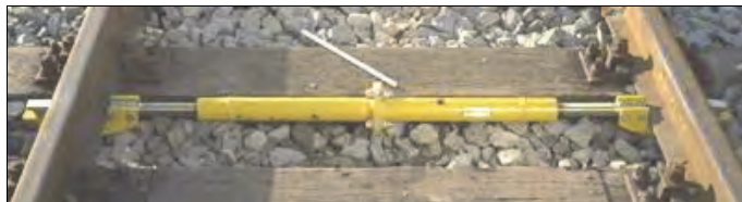
Rys. 3.29. Ściąg szynowy [74]
