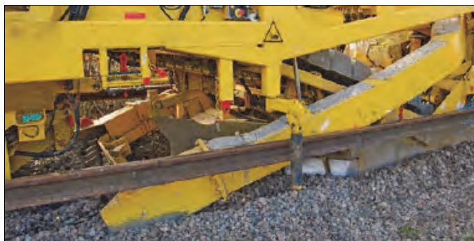
Rys. 9.77. Wybieranie podsypki z toru maszyną P95T [67]
