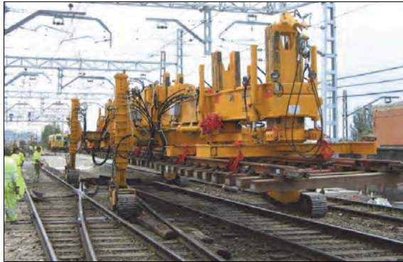
Rys. 10.39. Podnośniki RPK-40 firmy Plasser & Theurer [68]
