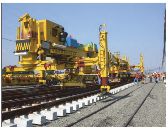
Rys. 10.38. Układanie rozjazdu na warstwie podsypki maszyną WM-40/PK [68]
