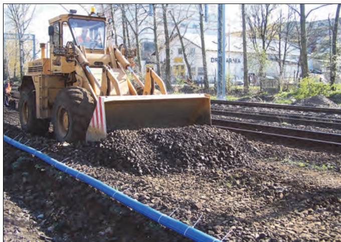
Rys. 11.10. Wybieranie warstwy podsypki (J. Zariczny)
