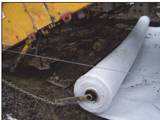
Rys. 11.33. Budowa maszyny AHM 800 R: zespół dwóch płyt wibracyjnych (z lewej); rolka geowłókniny (z prawej) (J. Zariczny)
