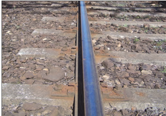
Rys. 11.4. Zdjęcie przytwierdzeń i połączeń szyn (J. Zariczny)
