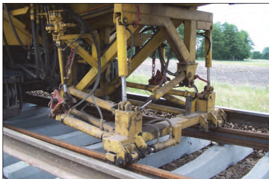
Rys. 9.73. Zespół układania nowych szyn na podkładach w zespole PUN (J. Zariczny)
