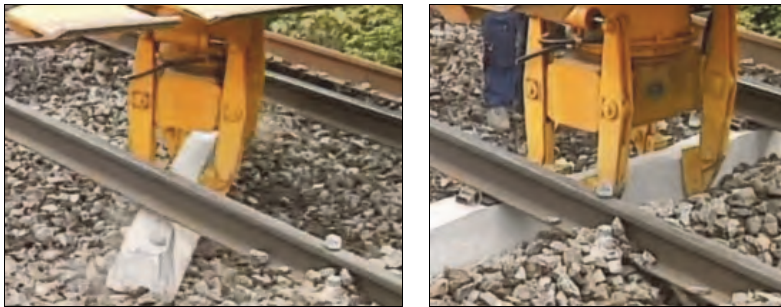
Rys. 4.19. Wbudowanie nowego podkładu [75]
