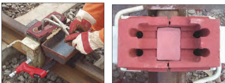
Rys. 7.31. Wkładanie zatyczki w formę w metodzie PLA [102]
