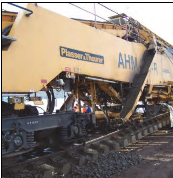
Rys. 11.36. Wysypywanie tłucznia w tor zspem bocznym w maszynie AHM 800R (J. Zariczny)
