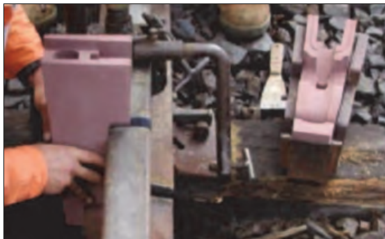
Rys. 7.23. Dopasowanie formy do szyny [142]
