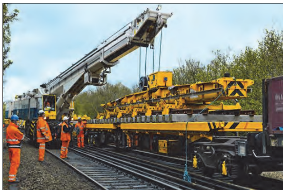
Rys. 10.19. Wymowanie przęsla rozjazdu z wagonu TSI-UIC [64]
