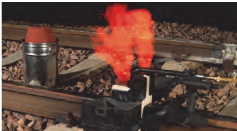
Rys. 7.30. Podgrzewanie końców szyn [57]
