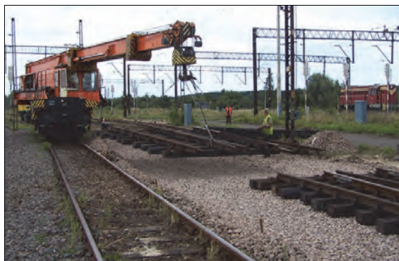
Rys. 10.16. Transport bloku rozjazdu żurawiem EDK 300 (J. Zariczny)
