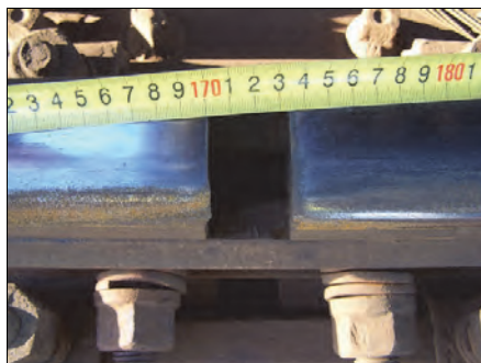
Rys. 4.38. Luz w styku 35 mm w temperaturze 15°C
