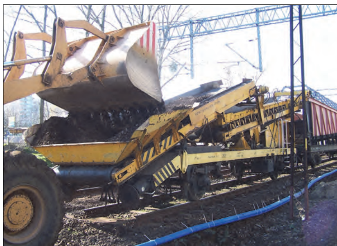
Rys. 11.11. Załadunek podsypki na wagony (J. Zariczny)
