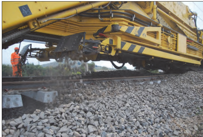
Rys. 6.14. Wsypanie oczyszczonej podsypki w tor [68]
