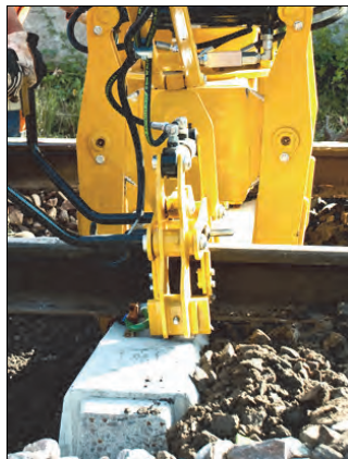
Rys. 4.16. Osprzęt do zapinania przytwierdzenia PANDROL FASTCLIP [75]
