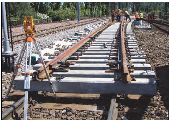
Rys. 10.14. Montaż rozjazdu w pobliżu miejsca jego wbudowania (J. Zariczny)
