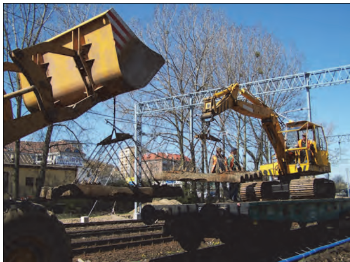
Rys. 11.8. Układanie podkładów na wagonie (J. Zariczny)
