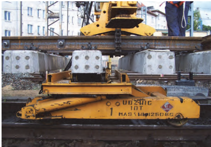
Rys. 10.23. Transport nowego rozjazdu na wózkach jezdnych urządzenia UWR (J. Zariczny)
