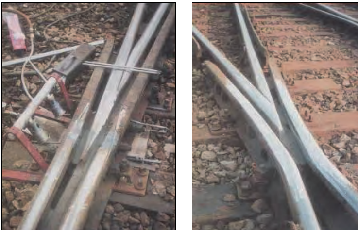
Rys. 4.27. Regeneracja krzyżownicy zwyczajnej [54]
