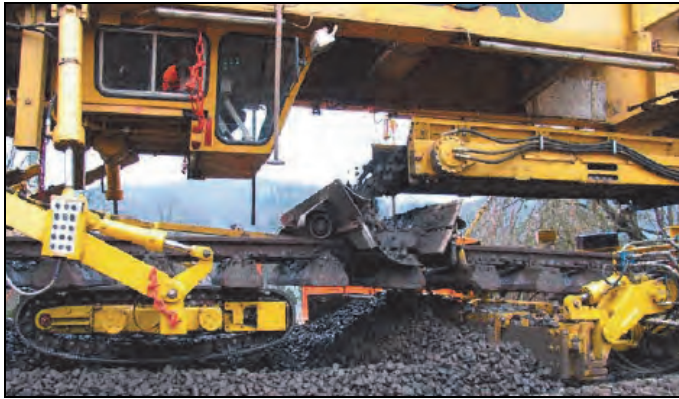
Rys. 11.28. Układanie subwarstwy tłucznia maszyną SVV100 [125]
