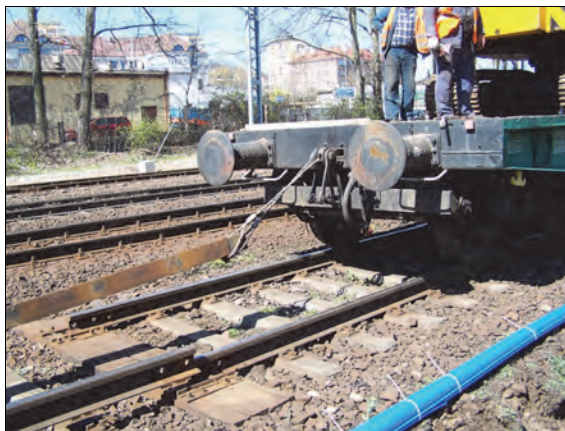
Rys. 11.5. Przeciągnięcie szyn kolejowych (J. Zariczny)
