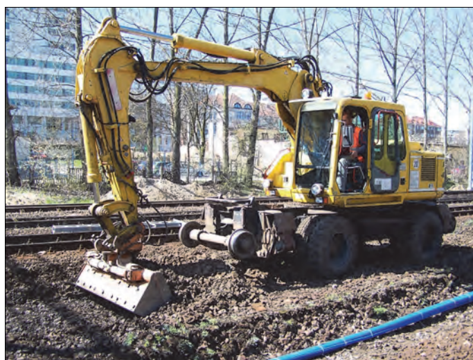
Rys. 11.9. Odspajanie warstwy podsypki (J. Zariczny)
