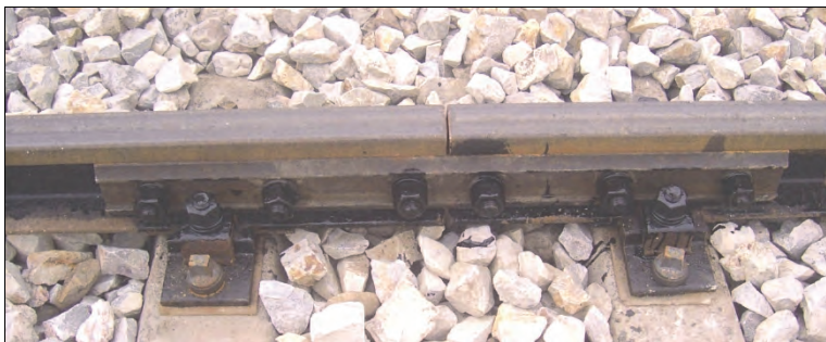
Rys. 3.37. Konserwacja złązek szynowych
