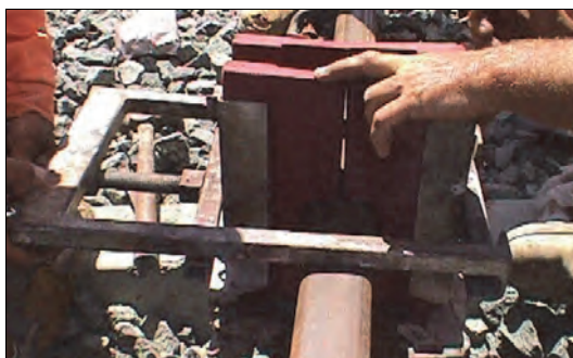
Rys. 7.24. Założenie form wraz z mocowaniem obejmami [142]
