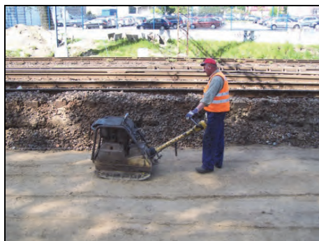
Rys. 11.18. Zagęszczanie warstwy podłoża (J. Zariczny)
