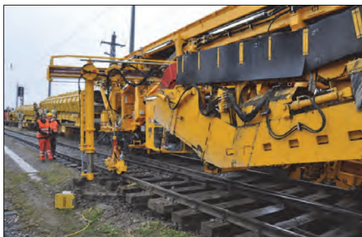
Rys. 6.52. Oczyszczarka URM700 na rozjeździe kolejowym [68]
