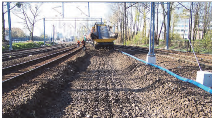
Rys. 11.12. Wybrana warstwa podsypki tłuczniowej (J. Zariczny)
