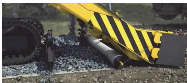
Rys. 6.43. Układanie warstwy separującej z geowłókniny przez oczyszczarkę ZRM350 [68]
