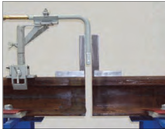
Rys. 7.21. Regulacja wysokości palnika [15, 118]:
