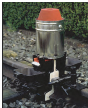
Rys. 7.28. Ustawienie tygla jednorazowego na formie [38]
