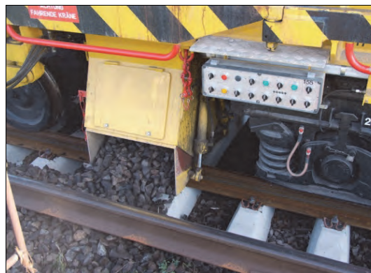
Rys. 9.83. Wsypywanie wybranej podsypki w tor maszyną SUZ 500 UVR [68]
