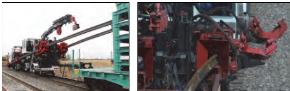
Rys. 9.15. Przeciąganie i mocowanie szyn w obejmach w maszynie RUM [63]
