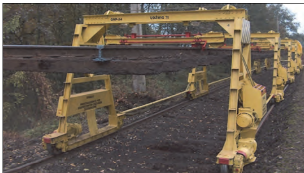
Rys. 9.26. Transport wyjętego przęsła na wagony platformy suwnicami SBT-5 [70]
