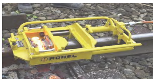
Rys. 7.34. Obcięcie wypływki [74]
