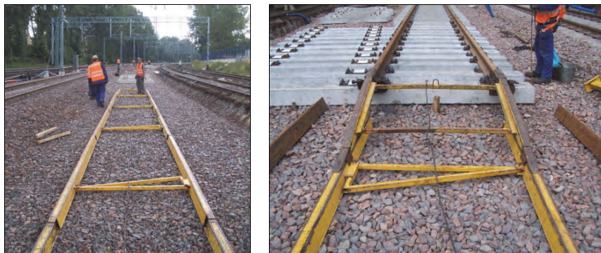
Rys. 10.21. Tor pomocniczy urządzenia UWR (J. Zariczny)
