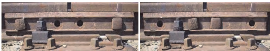
Rys. 3.23. Łubki skręcone dwiema śrubami (G. Stencel)
