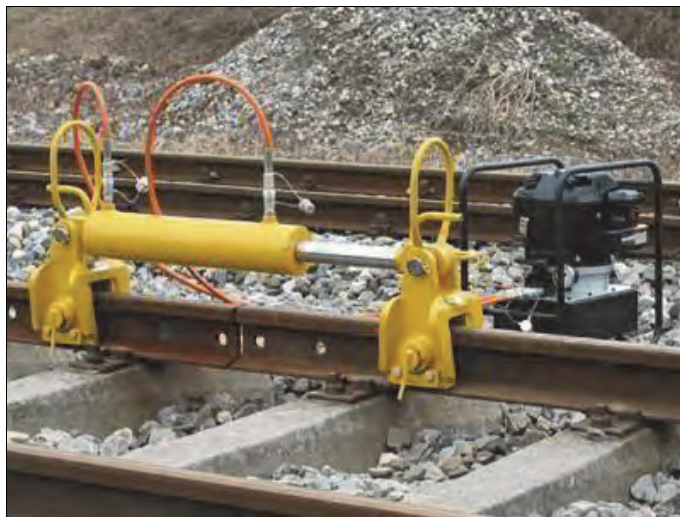
Rys. 4.43. Hydrauliczne urządzenie do nasuwania szyn [74]
