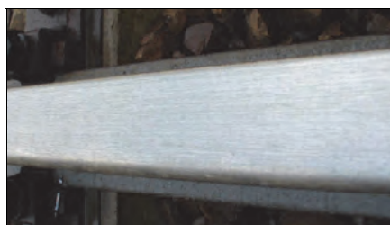
Rys. 8.22. Szyna po szlifowaniu [29]
