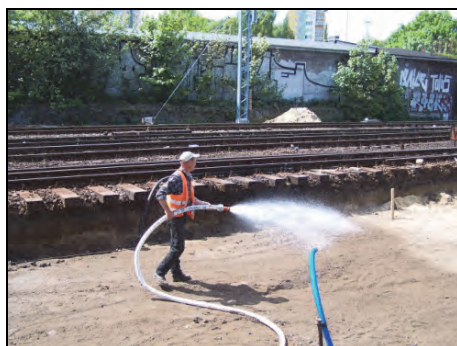
Rys. 11.18. Zagęszczanie warstwy podłoża (J. Zariczny)
