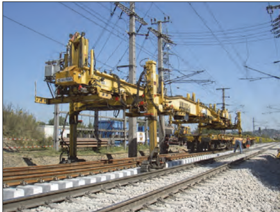
Rys. 10.40. System układania rozjazdów WM500U firmy Plasser & Theurer [68]
