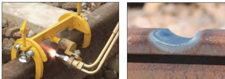
Rys. 7.37. Wycięcie fugi palnikiem gazowym [57]
