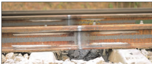
Rys. 7.18. Zgrzana szyna kolejowa z obciążoną wypływką [68]
