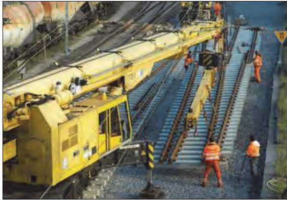
Rys. 10.17. Żuraw firmy Kirow z podwieszonym trawersem [64]
