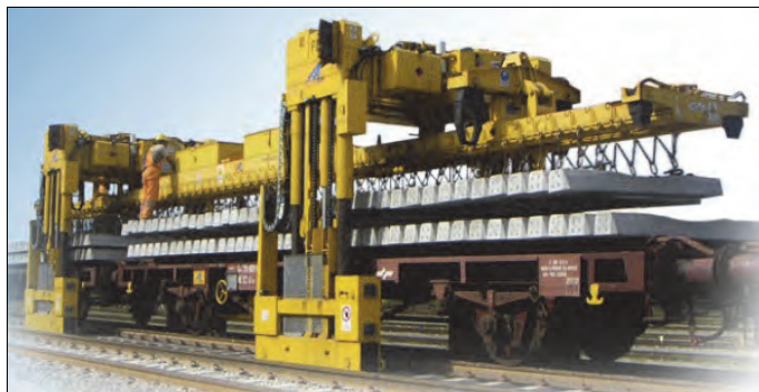
Rys. 9.43. Przemieszczanie się suwnicy PTH-350 po torze podsunicowym [62]
