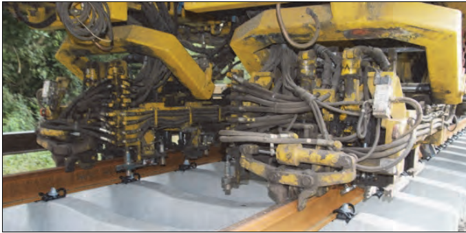
Rys. 9.92. Urządzenia do montażu przytwierdzeń maszyny RU800 [68]
