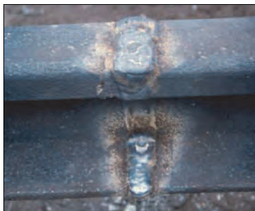
Rys. 7.40. Spina wykonana elektrycznie półautomatem [144]
