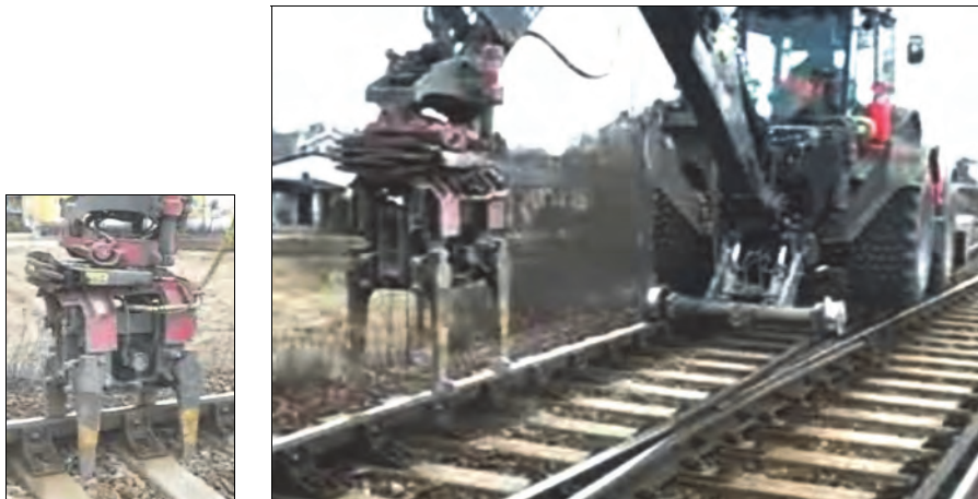
Rys. 4.5. Podbijanie rozjazdu kolejowego [73]
