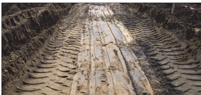
Rys. 11.14. Wstępne wyprofilowanie podłoża pod warstwą ochroną (J. Zariczny)
