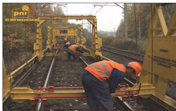
Rys. 9.25. Mocowanie przęseł torowych do suwnic SBT-5 [70]
