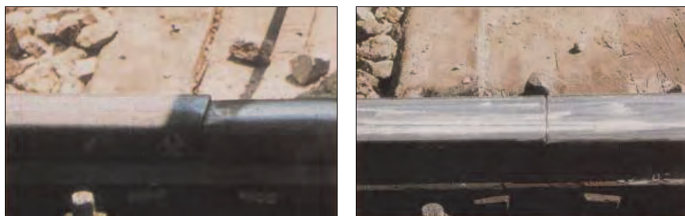
Rys. 4.26. Regeneracja uszkodzonych szyn w styku [54]
