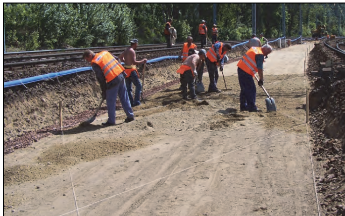
Rys. 11.19. Ręczne profilowanie torowiska pod warstwę ochronną (J. Zariczny)
