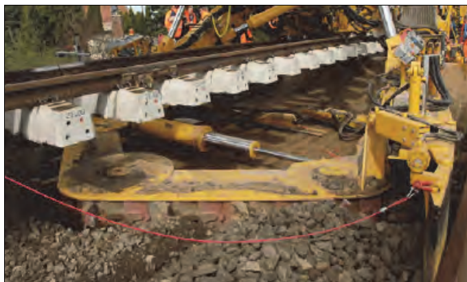
Rys. 11.42. Drugi łańcuch wybierakowy w maszynie RPM RS 900 [145]
