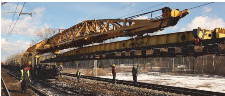
Rys. 9.30. Wyjęcie przęsła torowego z wykorzystaniem trawersu żurawia UK-25 [69]
