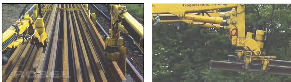
Rys. 9.8. Rozładunek i załadunek szyn w systemie firmy Robel [74]
