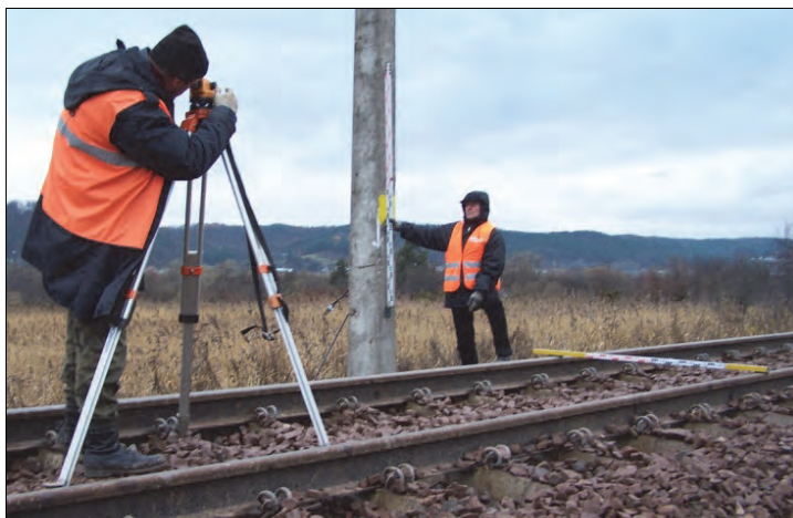
Rys. 5.33. Pomiar przewyższenia znaku względem toku szynowego (J. Zariczny)
