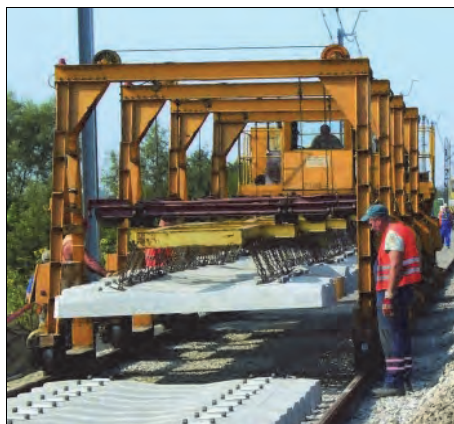
Rys. 9.41. Układanie podkładów za pomocą suwnic SBT-5 [60]
