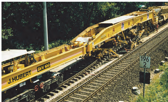
Rys. 11.25. Układanie i zagęszczanie warstwy kruszywa maszyną SVV100 [68]
