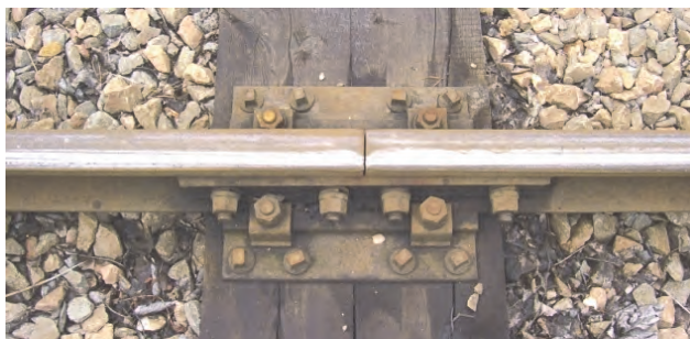
Rys. 3.24. Złącze szynowe po zakończeniu robót
