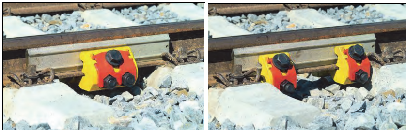
Rys. 3.19. Imadło do zabezpieczenia pękniętych szyn [74]
