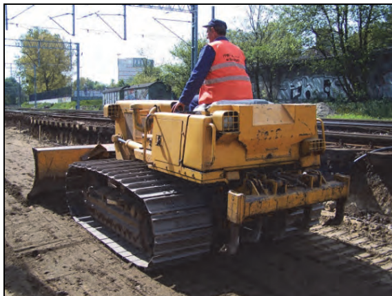
Rys. 11.17. Profilowanie warstwy podłoża (J. Zariczny)
