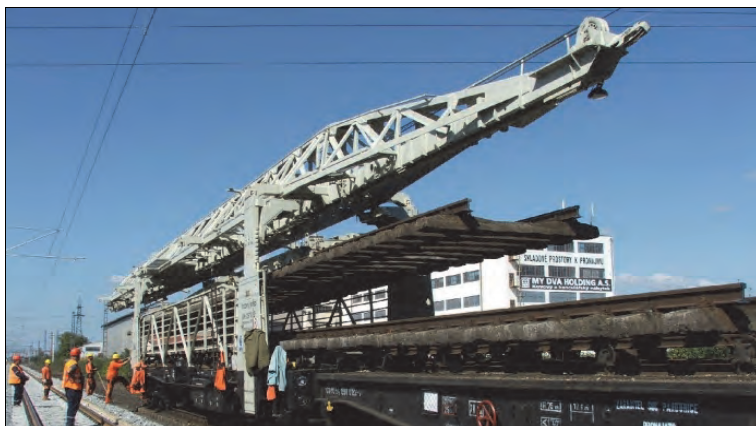
Rys. 9.31. Ułożenie przęsła na platformie żurawia UK-25 [81]
