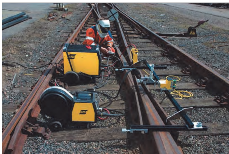
Rys. 4.29. Traktor spawalniczy Railtrac BV1000/BVR1000 firmy ESAB [58]
