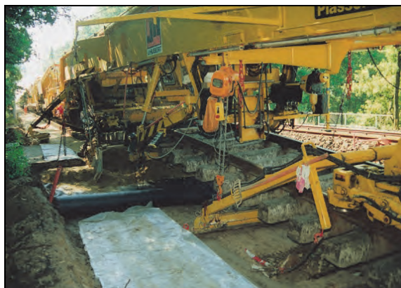
Rys. 11.26. Zagęszczanie podłoża i wsypywanie kruszywa maszyną SVV100 [68]
