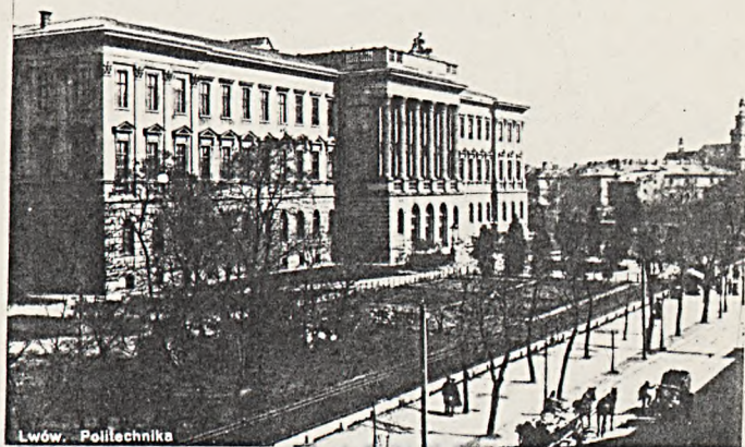
BUDYNEK POLITECHNIKI LWOWSKIEJ
