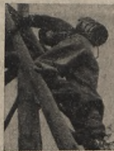
Rys. 6. Wejście na wieżę.
