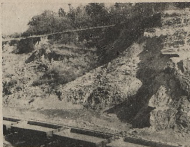
Rys. 4. Osuwisko zbocza w wykopie kolejowym.
