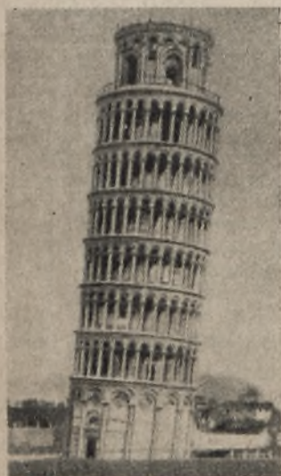
Rys. 2. Wieża w Pizie. Pochylenie wieży na skutek nierównomiernej ściśliwości podłoża.
