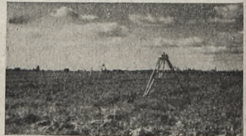
6. Rząd statywów po przejściu z drutami i niwelacją
