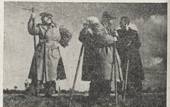
3. Grupa pomiarowych z drutami inwarowymi
