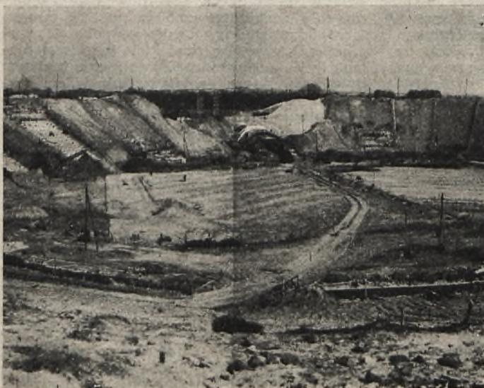
Rys. 3. Ogólny widok widowni stadionu w początkowej fazie montażu pierwszych sektorów
