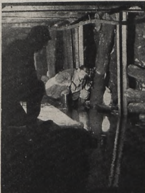
Rys. 2. Woda w chodniku ogromnie utrudnia pracę
