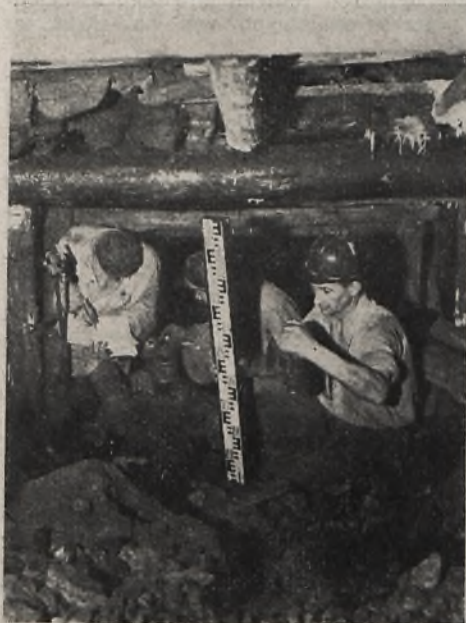
Rys. 1. Uciążliwa pozycja ciała przy prowadzeniu pomiarów w niskich chodnikach. Obliczenia różnic wykonuje się bezpośrednio po pomiarze
