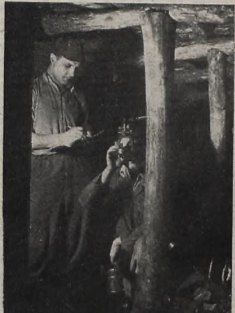
Rys. 3. Bardzo często grozi możliwość oberwania się stropu
