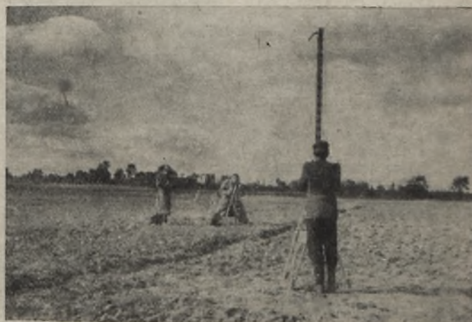
Rys. 2. Niwelacja wskaźników odczytowych bazy
