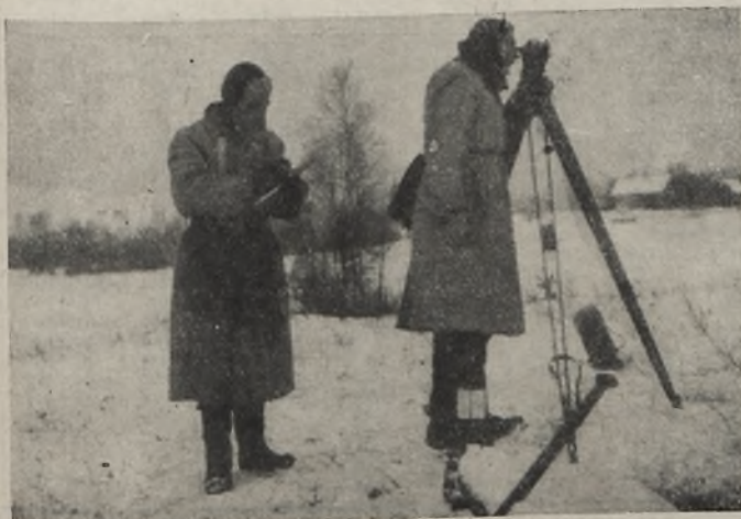
Rys. 4. Pomiar kątów załamania poligonu
