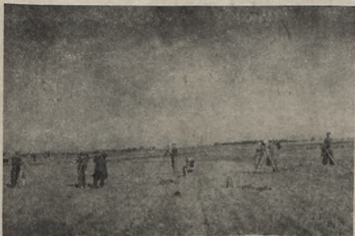
Rys. 1. Pomiar bazy drutami inwarowymi
