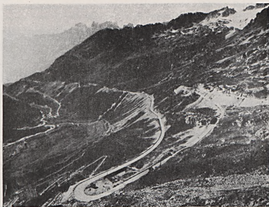
Widok na Sustenstrasse w Szwajcarii — podczas budowy
